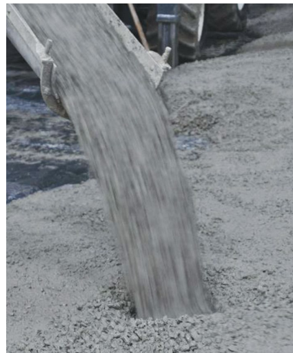
Imagen 4. Muestra de la facilidad de vertido, colocación y extendido del hormigón fluido.
