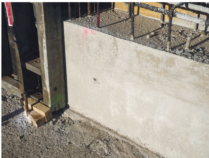
Imagen 7. Aspecto del acabado de la superficie en muros con hormigón fluido.
