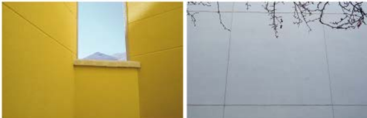
Entrecalles resultantes de extraer los berenjenos
