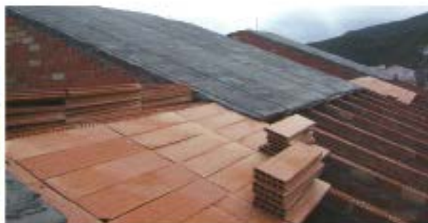
El tablero de rasillones en primer término, y la capa de mortero al fondo
