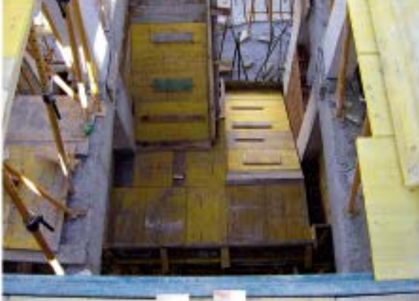
Encofrado de losa sin zancas
