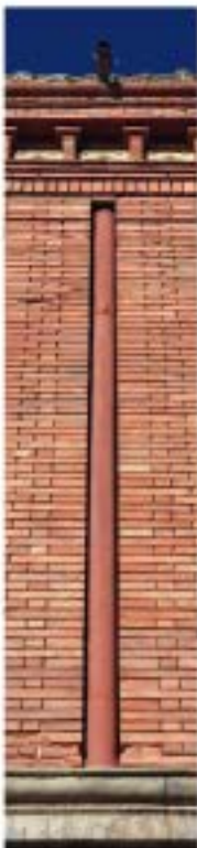
Bajante de chapa pintada
