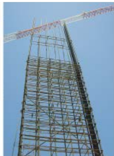
Armadura de pantalla antes de encofrar
