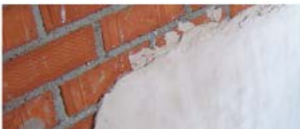
Guarnecido de yeso por una cara de ladrillo fonoacústico
