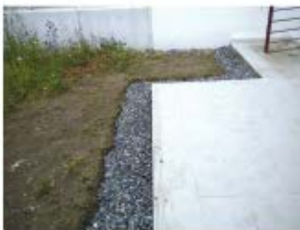
Zanja de drenaje con grava
