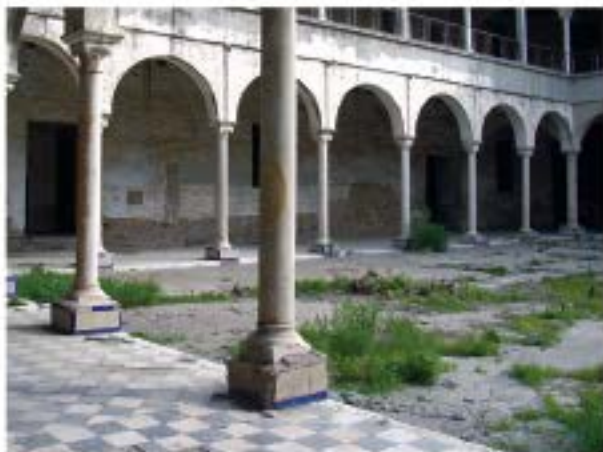
Hilera de columnas formando galería-claustro
