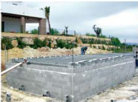
Exterior: construcción forjado sanitario de viguetas autorresistentes
