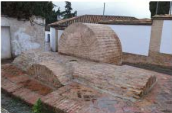
Bóveda de aljibe (dos bóvedas de cañón perpendiculares cortándose)
