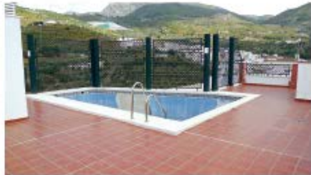
Juntas de dilatación en plataforma piscina (en colores más blancos)
