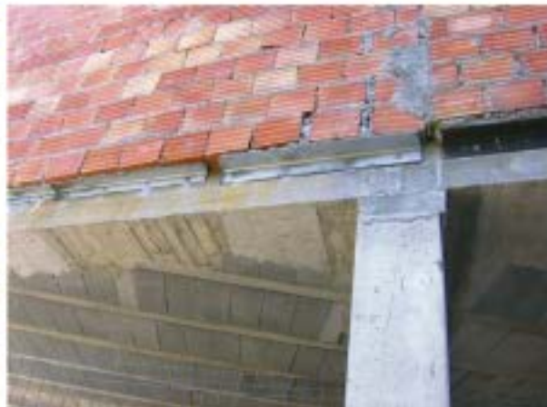
Angular atornillado a forjado para sustento del voladizo del cerramiento
