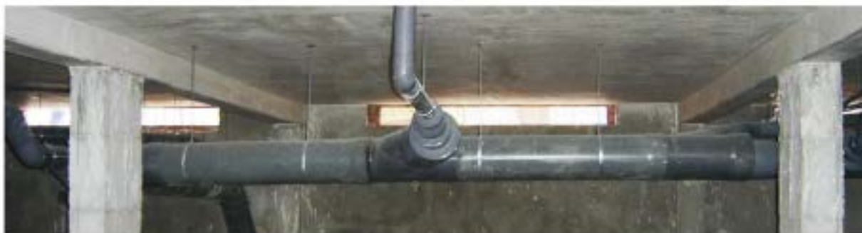
Entronque de bajante a gran colector
