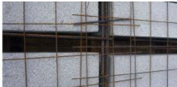
Mallazo en capa de compresión de forjado bidireccional
