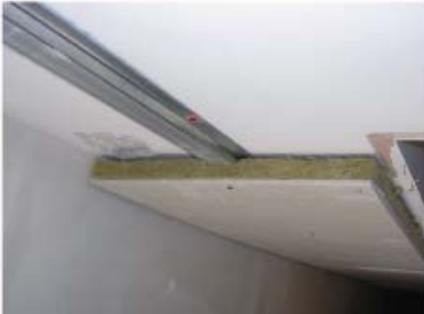
Atomillando a perfil placas estándar con aislante
