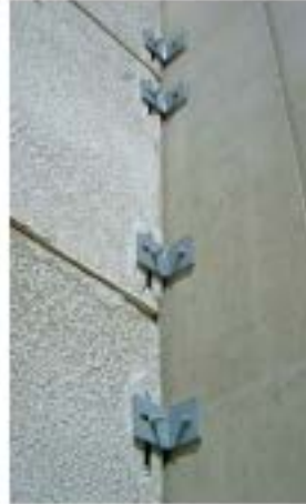
Trabazón entre dos pantallas de hormigón Móvil con angulares
