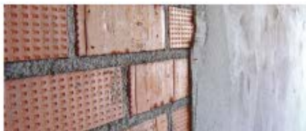
Enfoscado por la otra cara para cumplir atenuación acústica
