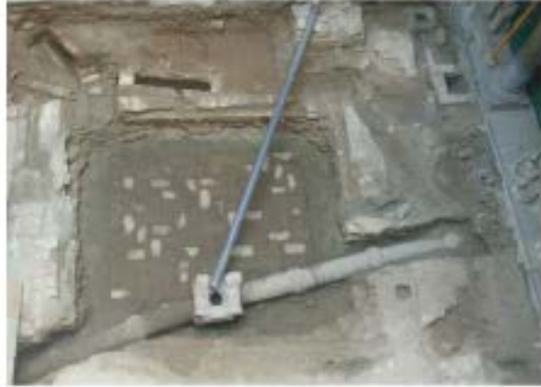
Arqueta de ladrillo tosco
