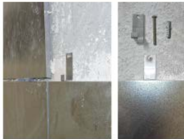
Sistema de anclaje oculto de aplacado
