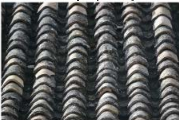
Detalle tejado tradicional de tejas curvas viejas
