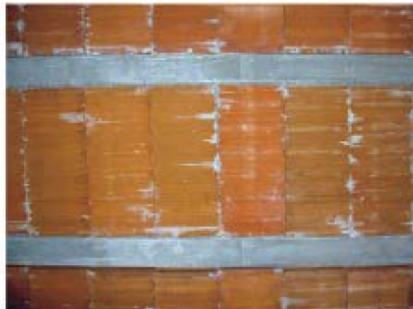
Bovedillas cerámicas en forjado unidireccional
