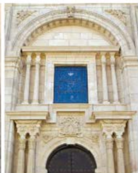
Arco cegado (el superior) o ciego
