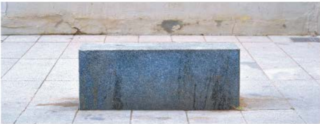
Acera contra edificio
