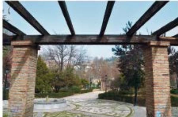
Viga de madera en pérgola
