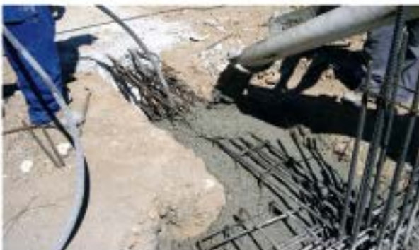
Hormigonando zuncho-riestra entre cimentación antigua y nueva
