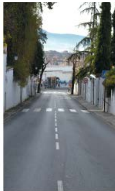
Calzada de asfalto sin cuneta
