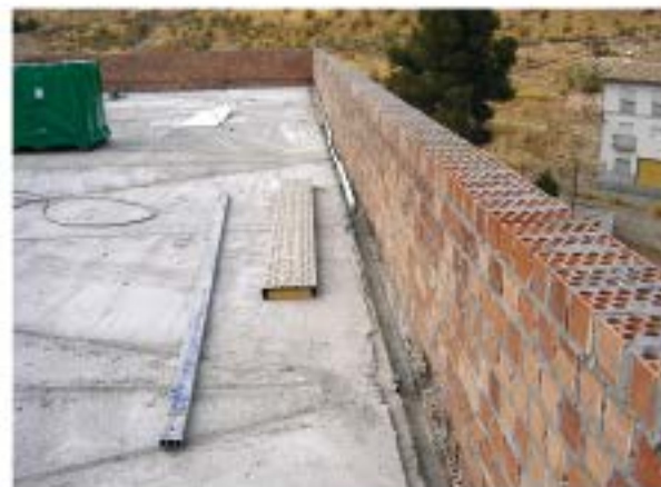
Preparando junta perimétrica en azotea
