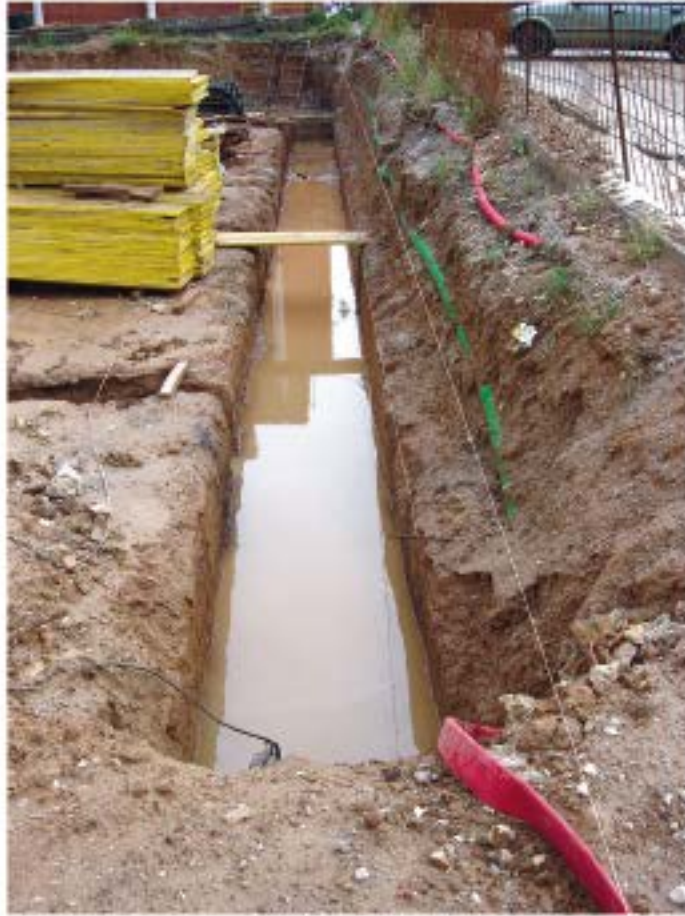
Zanja para zapata corrida de muro
