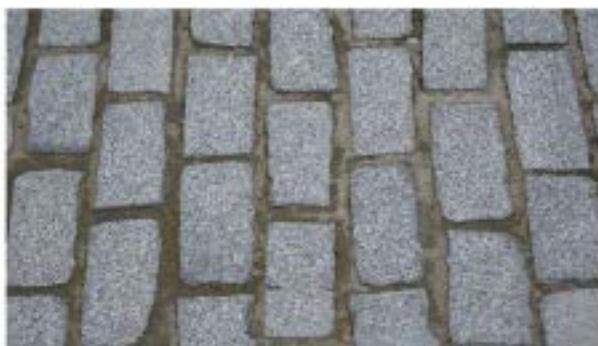
Adoquín rectangular de granito
