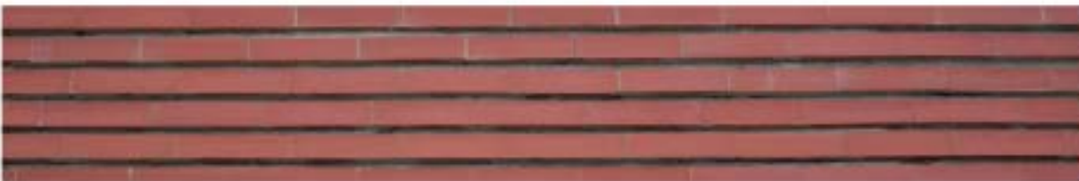
Tendeles rehundidos, llagas prácticamente inexistentes. Se hace así para potenciar la horizontalidad
