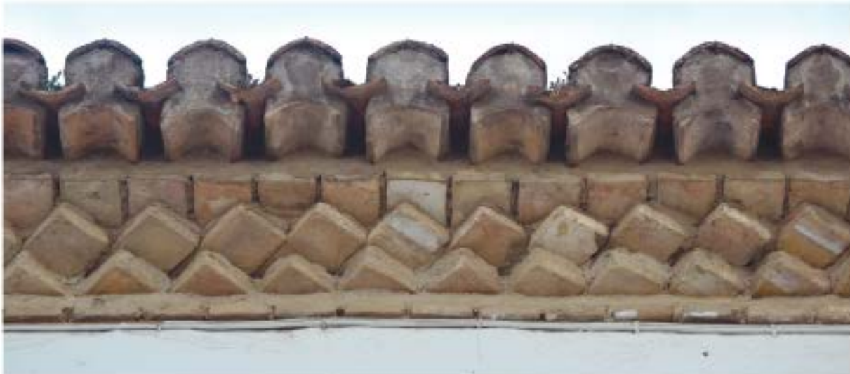
Alero sobre cornisa de ladrillo en "pico de gorrion"
