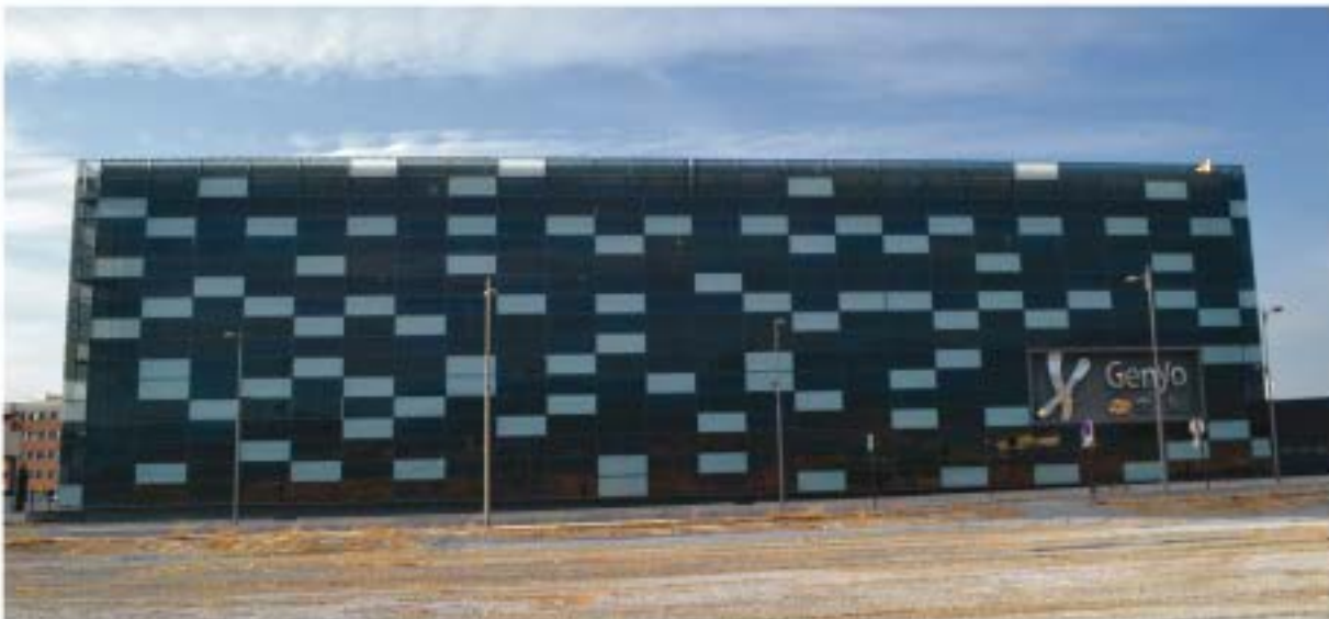
Fachada de vidrio ventilada fotovoltaica
