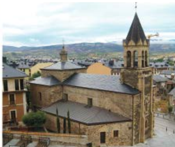
Tejado de chapa (abajo) y de pizarra (arriba)
