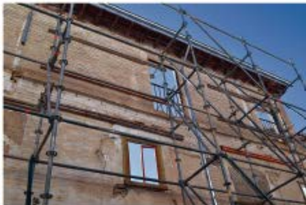
Colocando grupos de tornapuntas en estabilizador de fachada
