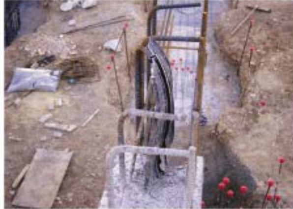
Cinta de pvc colocada en junta de dilatación vertical
