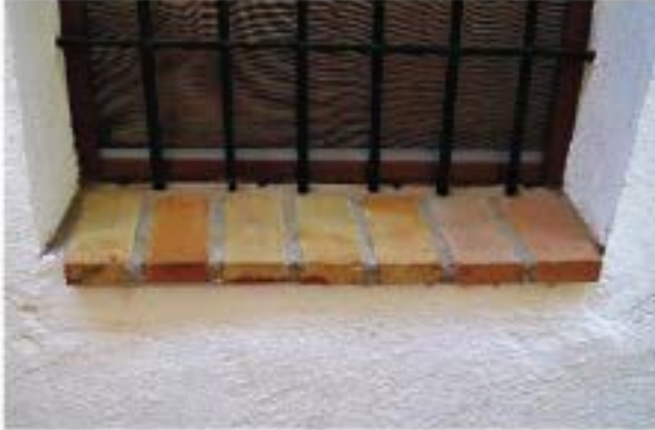
Alféizar de ladrillo
