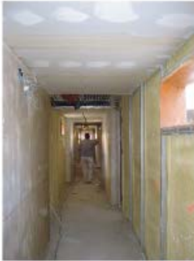
Enrastrelado para recibir revestimiento de chapa
