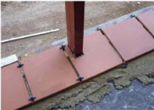
Crucetas separadoras de baldosas de gres, para junta ancha
