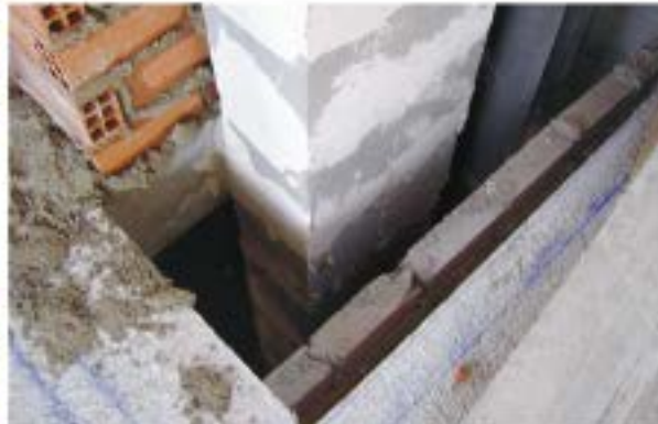
Patinillo, antes de cerrar, para conductos de ventilación y otros
