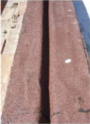
Junta de dilatación entre pretilas de cubierta Preparación doblando la lámina en fuelle
