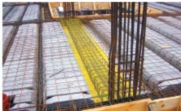
Zuncho en forjado, de pilar a pilar
