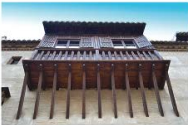
Balconada sobre jabalcones de madera
