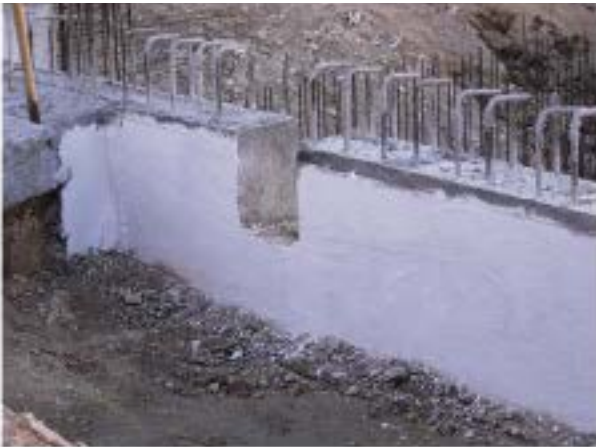
Impermeabilización muro-sótano con mortero hidrófugo
