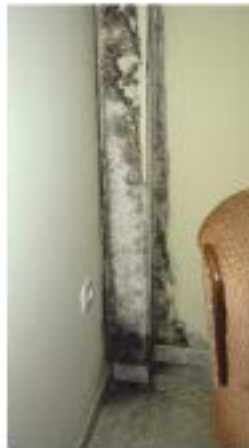
Violentas humedades de condensación en pilares de fachada
