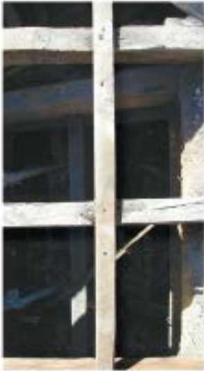
Vertical centro: rastrel para apoyo de placas
