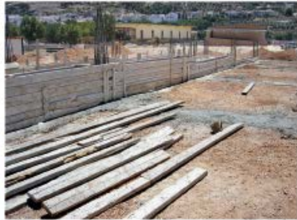
Encofrado rudimentario de madera
