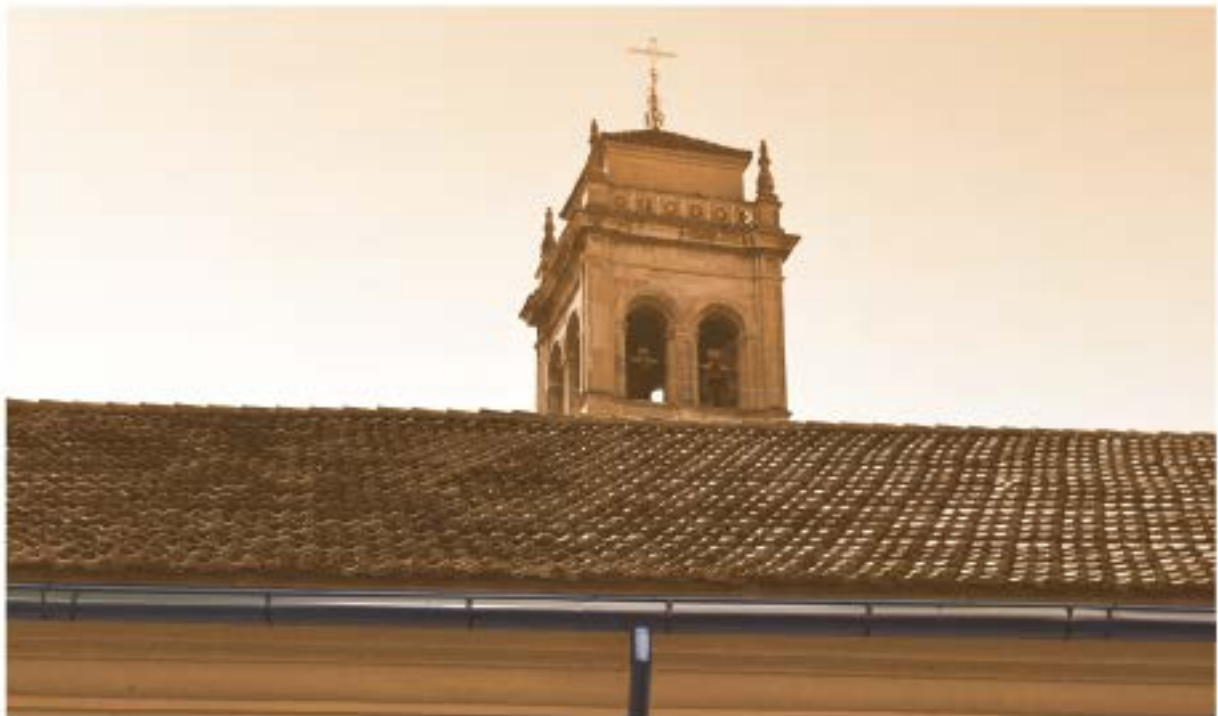
Canalón de sección semicircular en faldón de tejas planas . En el centro, la bajante
