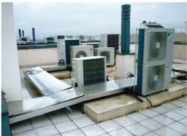
Bancada sobre cubierta pavimentada
