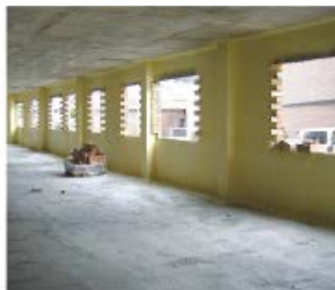
Hoja exterior embarrada con el aislante aplicado
