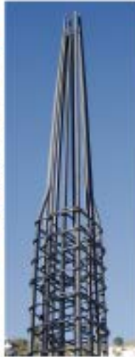
Armadura pilar
