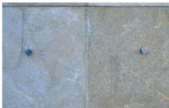
Aplacado fijado con tornillos y embellecedor en cabeza
