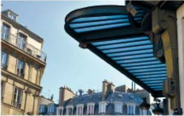
Marquesina de metal y vidrio
