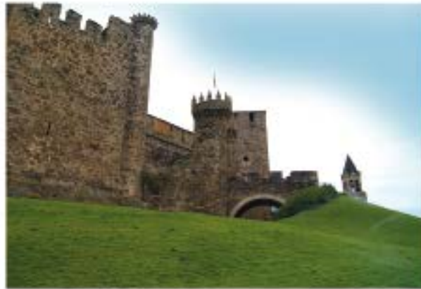
En primer plano, talud suave; al fondo, talud pronunciado
