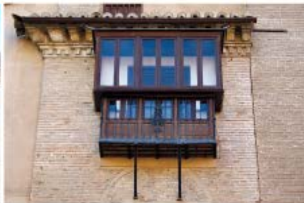
Balcón sobre par de jabalcones de hierro
