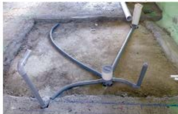
Instalación desagües baño con bote sifónico
