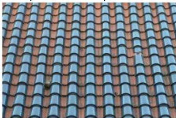
Tejado íntegro de tejas vidriadas (azul cobija, rojo canal)
