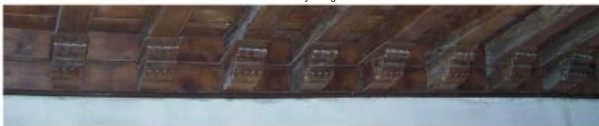
Ménsulas de madera
