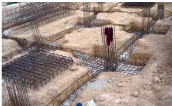
Cimentación: zunchos entre elementos aislados, aun sin hormigonar
