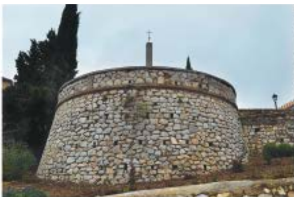
Muro curvo de mampostería ordinaria
