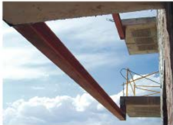
Viga de acero perfil en "H"
