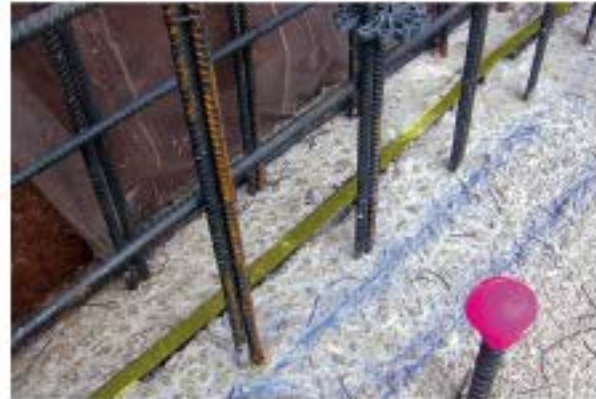
Junta hidroexpansiva colocada en junta de arranque de muro
