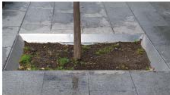
Alcorque de chapa de acero en pavimento de piedra
