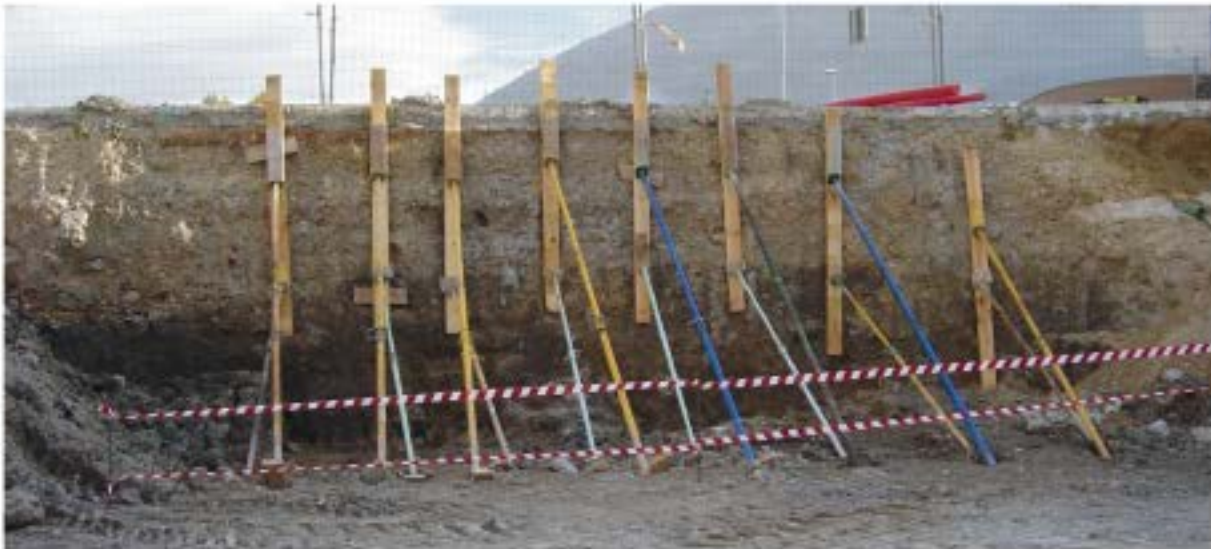
Entibación con tornapuntas
