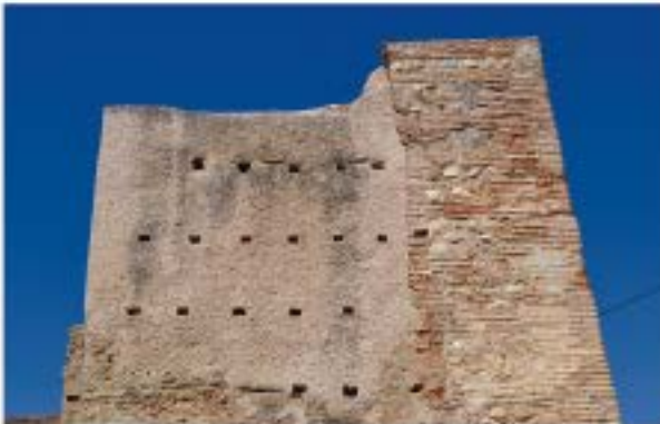
Mechinales para andamio
