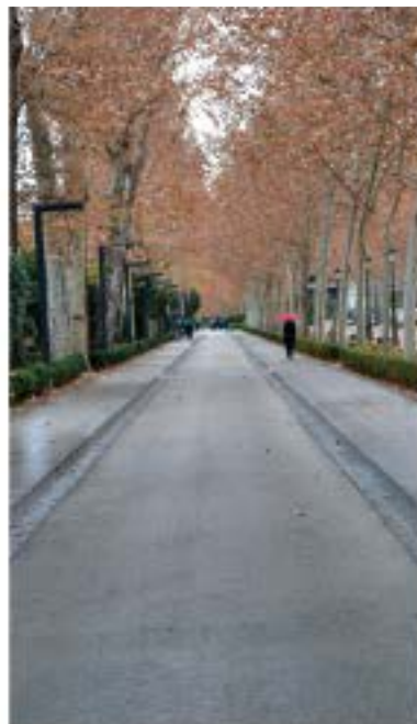
Calzada de hormigón con cunetas laterales
