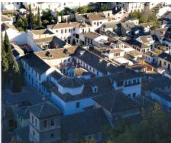
Tejados tradicionales de tejas árabes, con cobijas y canales
