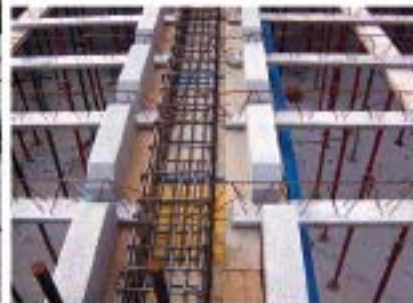
Semi-viguetas o viguetas semirresistentes
