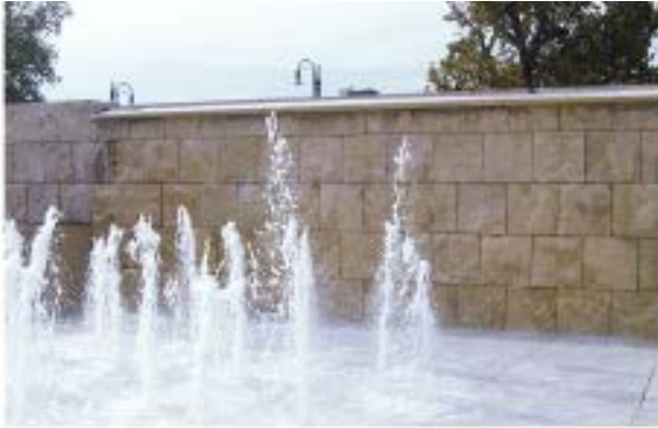
Sillares no careados (la cara vista no está labrada)
