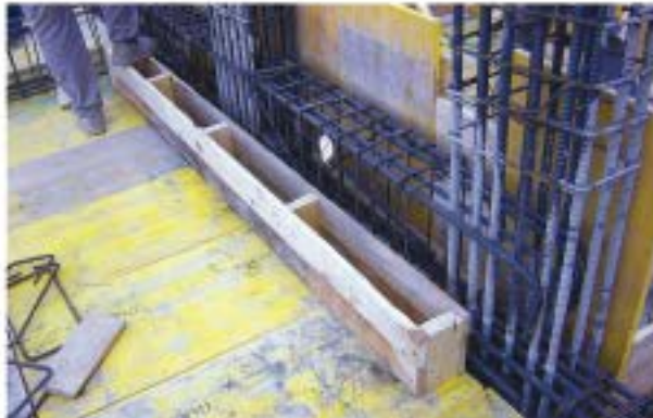
Formación de patinillo estrecho para la instalación de tuberías montantes
