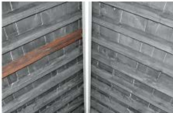
Cubierta de par e hilera
