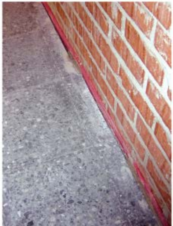
Solería colocada; lámina emergente en pared (roja), que tapaná el rodapié
