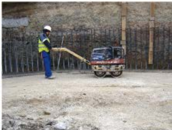
Compactando el relleno de mejora de una losa de cimentación
