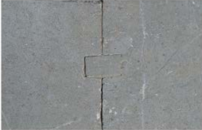
Trabazón con pletina de acero entre dos placas de piedra La pletina que hace de enlace no se ve en la fotografía Lo que se ve es un tapón realizado con la misma piedra
