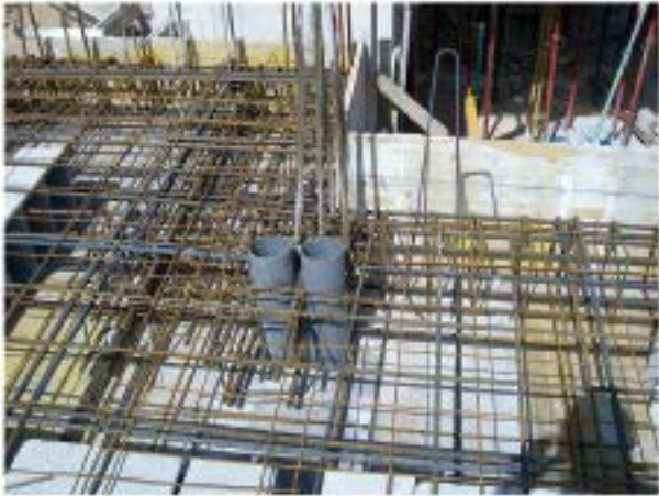
Preparación de doble pasamuros en un forjado , antes de hormigonar
