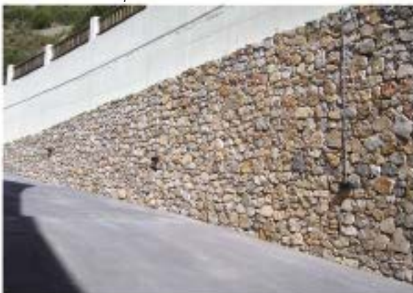
Muro de mampostería en seco
