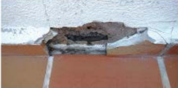
Cata para caracterizar el encuentro impermeabilización – paramento
