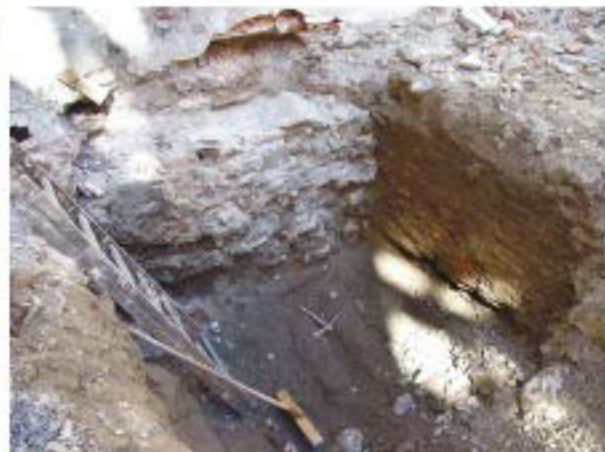
Calicata para caracterizar cimientos
