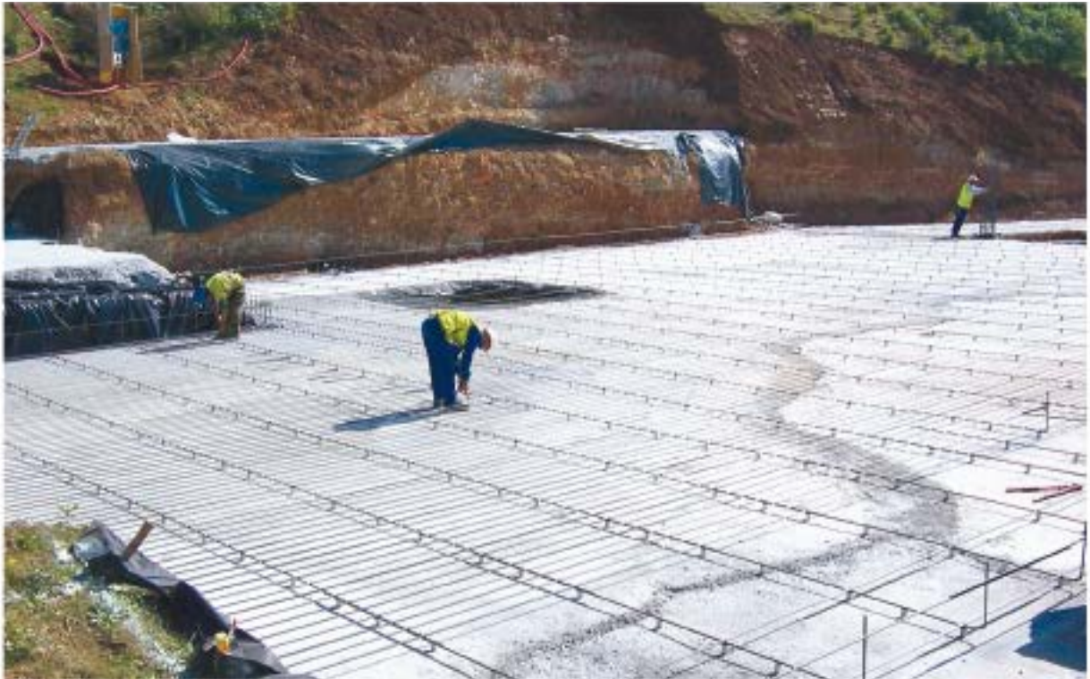
Armando cimentación superficial por losa
