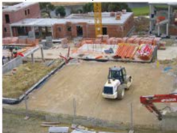
Compactación de explanada con maquinaria pesada
