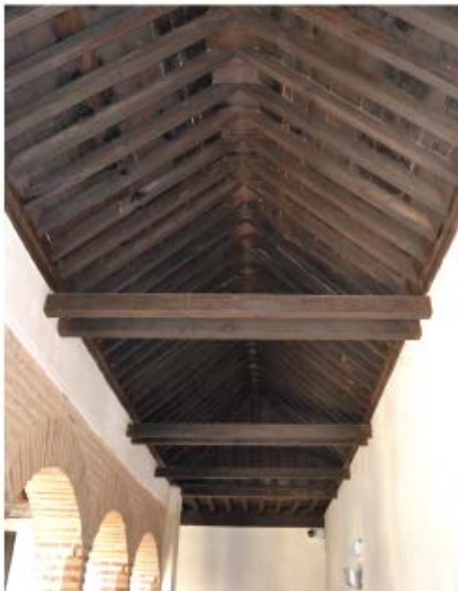
Doble tirante (los maderos horizontales de la foto) en una cubierta de "par e hilera"
