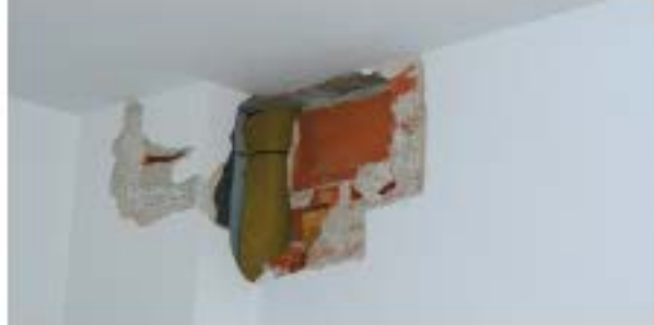
Cata para verificar el aislamiento de una bajante
