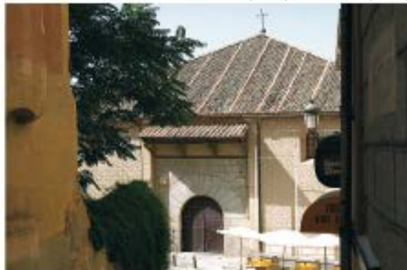
Singular: tejados a la segoviana, sólo con tejas canales y refuerzo de hiladas de cobijas
