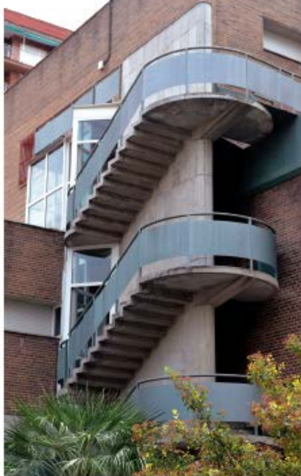
Escalera de hormigón sin zanca. Peldaños volados y ménsulas
