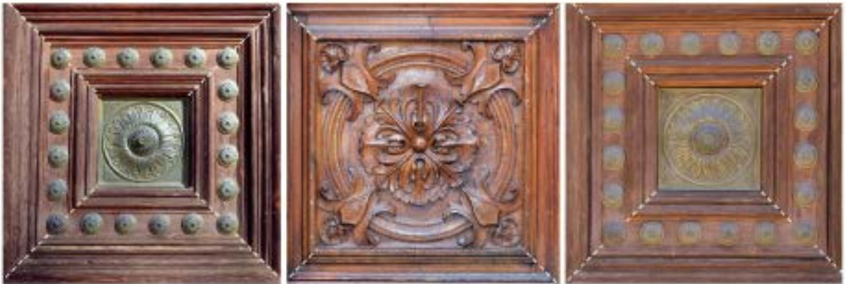
Uniones a inglete (se han marcado tenuemente con líneas punteadas)
