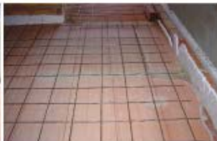
Mallazo de acero colocado
