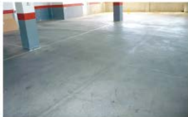
Pavimento continuo de hormigón fratasado
