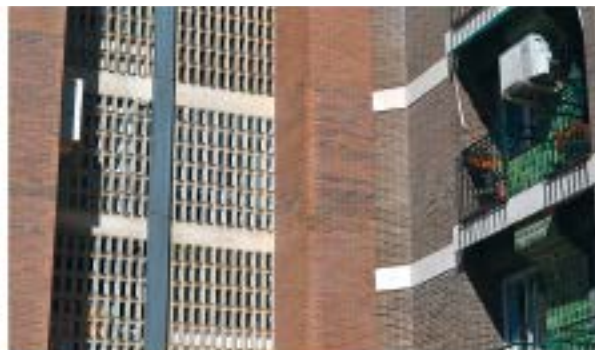
Contraste: el edificio de la dcha. no tiene emparchados los cantos; el de la izq. sí
