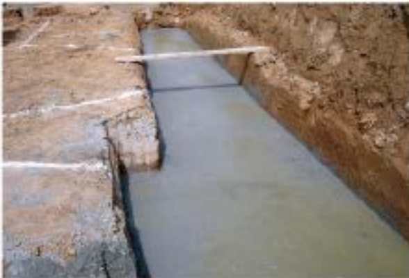
Hormigón en masa recién vertido en zapata corrida como base de limpieza
