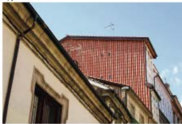
Tejas colocadas en vertical como tabique pluvial
