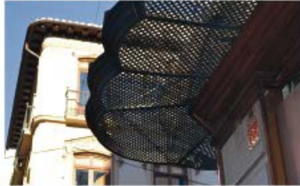
Arriba: marquesina que es continuación de la cubierta
