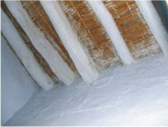
Forjado de rollizos con sobre-techo de cañizo
