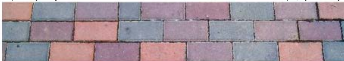
Adoquín rectangular de hormigón coloreado
