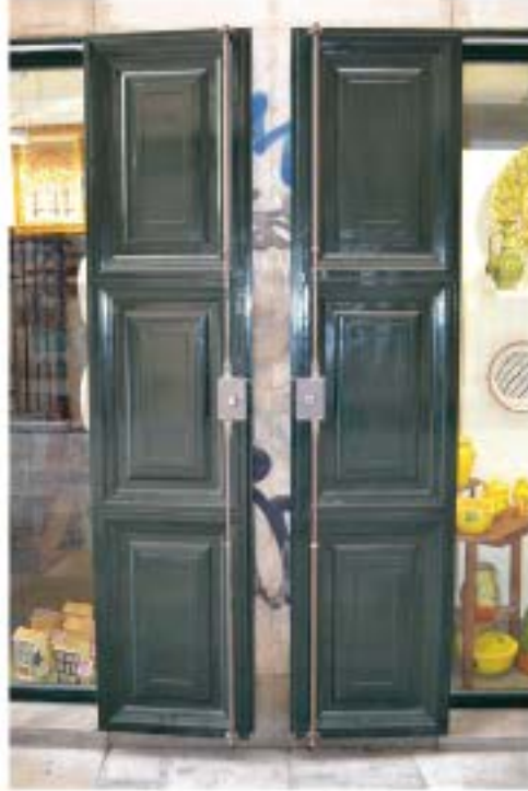
Fallebas de accionamiento central con llave
