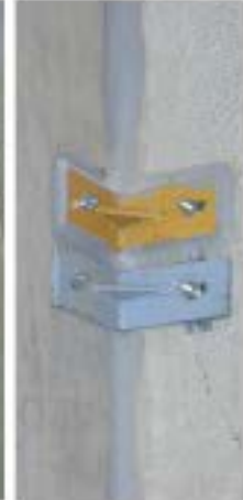
Trabazón entre dos pantallas de hormigón Móvil con angulares
