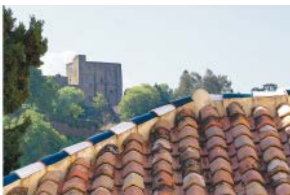
Tejas árabes (cobijas sobre canales) y vidriadas de varios colores
