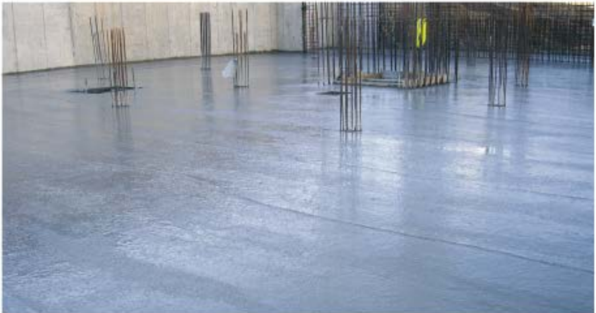
Losa de cimentación recién hormigonada
