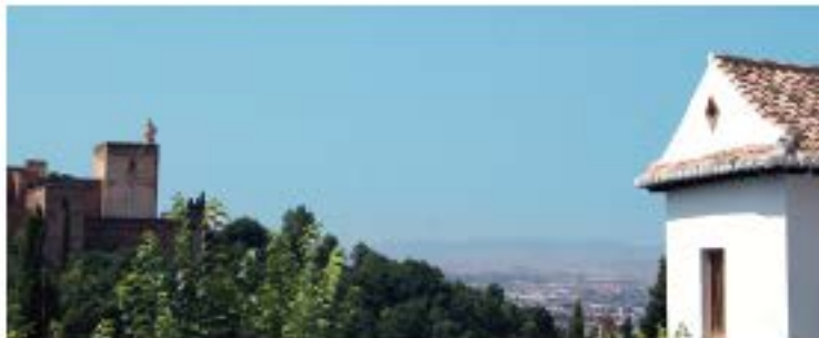
Hastial con hueco de ventilación de la cámara que encierra
