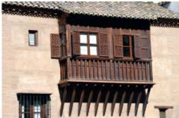
Balconada con celosía
