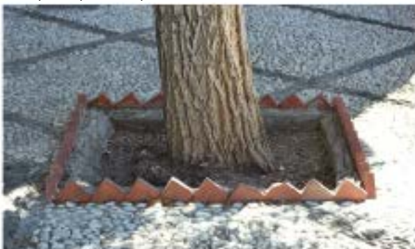
Alcorque de ladrillo en pavimento empedrado
