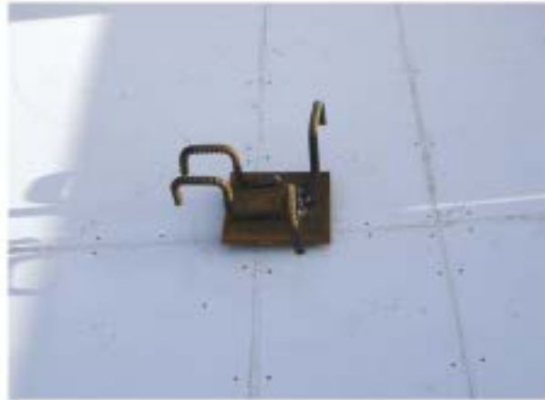
Pletina cuadrada = placa (en el caso de la imagen, de anclaje a futura losa)
