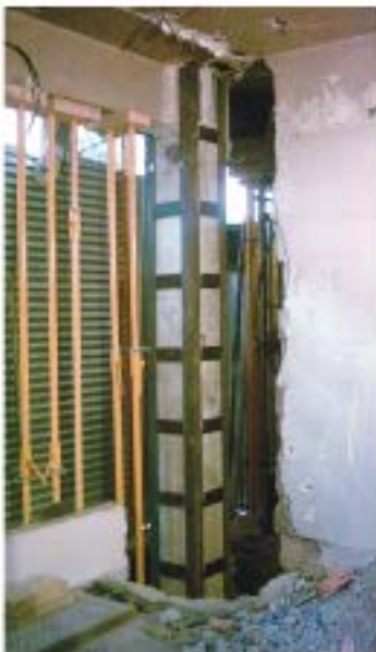
Refuerzo de pilar mediante empresillado
