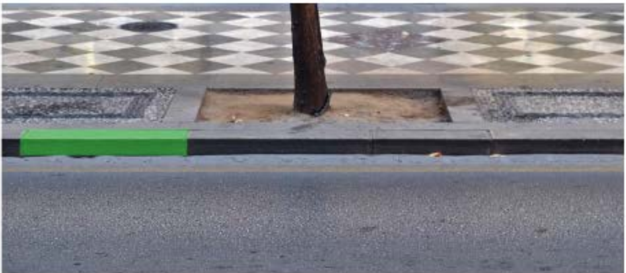
Bordillo de piedra
