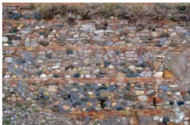
Muro de mampostería ordinaria con verdugadas de ladrillo
