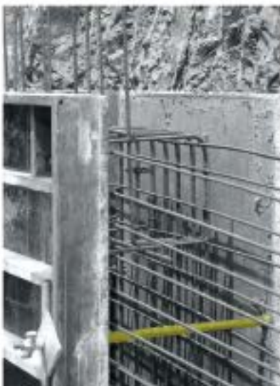
El tubo verde que ata los dos tableros quedará como espadín una vez extraída la barra
