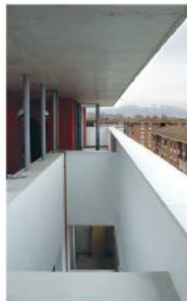
Voladizo de hormigón
