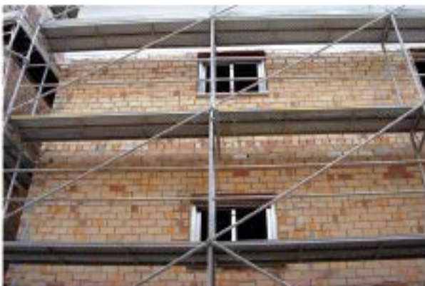
Tornapuntas en andamio tubular
