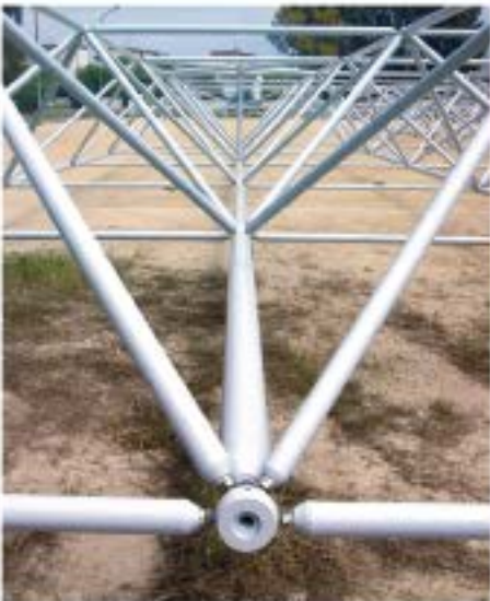
Estructura metálica espacial
