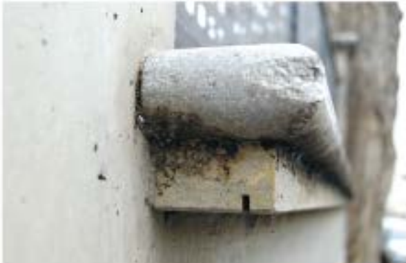
Goterón bajo bocel de piedra
