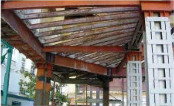
Empresillado en apeo de pilares (derecha: elem. horizontales de color blanco)
