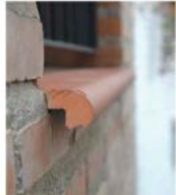
Bocel de gres con goterón
