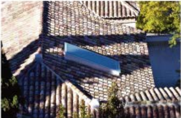
Ventana sobre-elevada sobre tejado de tejas
