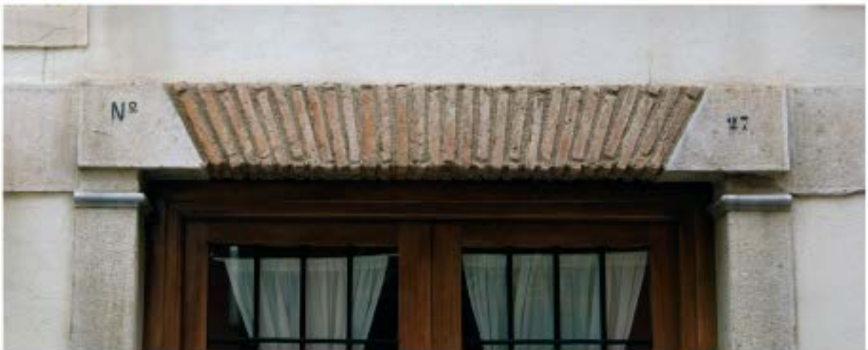
Distintos tipos de adintelados a sardinel
