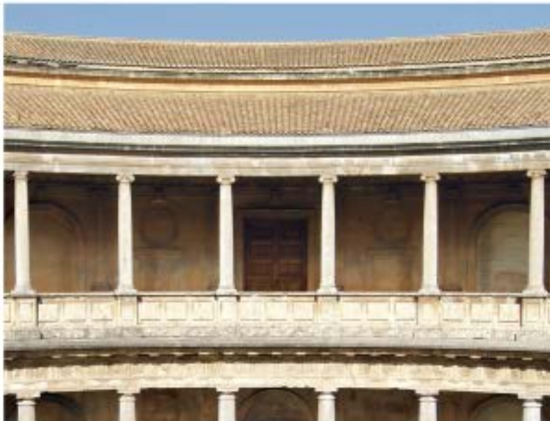
Galería a patio en planta primera
