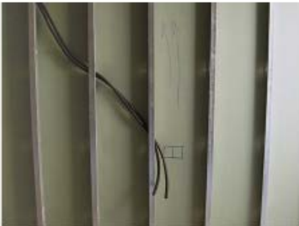
Replanteo tabique autoportante. Los perfiles de la imagen son los montantes
