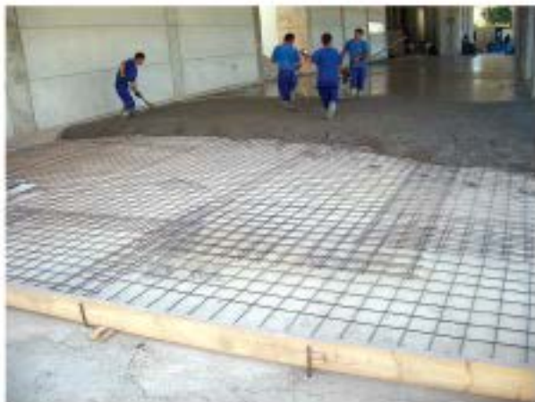
Hormigonando solera armada con mallazo
