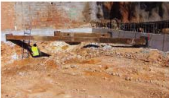
Sistema de acodalamiento (2 codales) de pantallas antes de excavar
