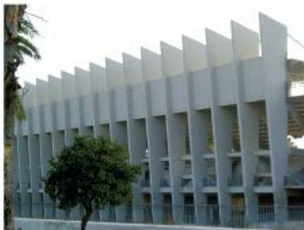
Hilera de pantallas de hormigón
