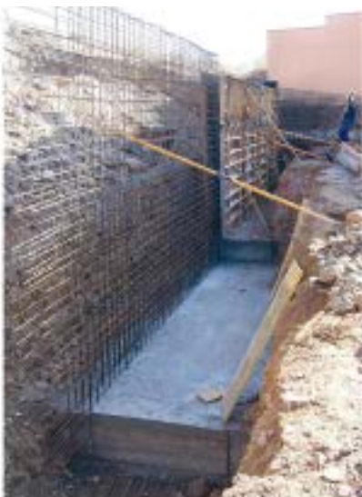
Muro convencional (la excavación ya está hecha)
