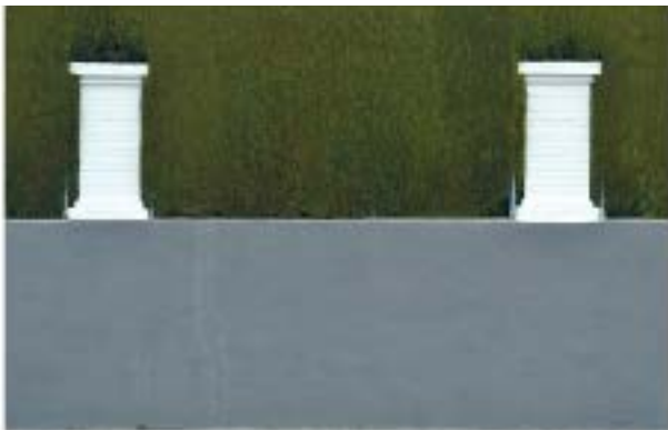
Tapia vegetal con zócalo revestido
