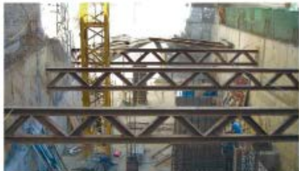
Acodalamiento de dos edificios colindantes
