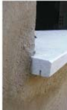
Goterón en alféizar de piedra artificial
