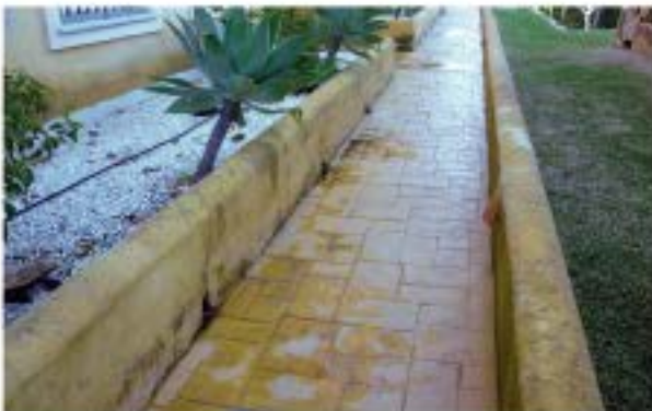
Pavimento de hormigón impreso
