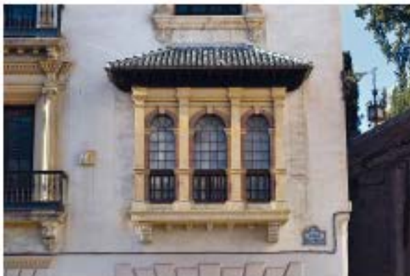
Balconada de fábrica de ladrillo arqueada
