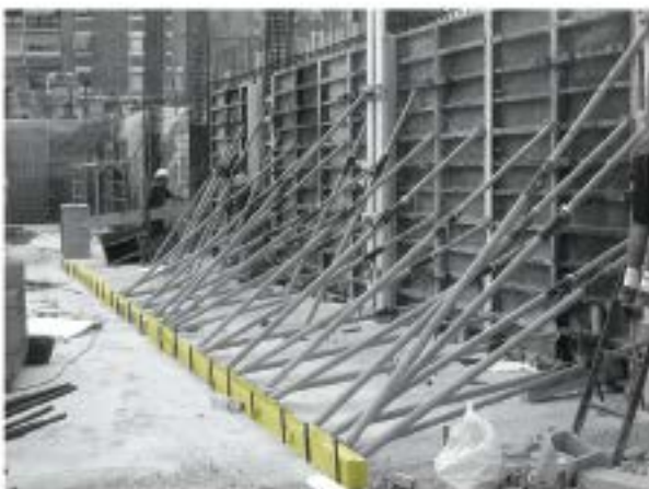
Durmiente apoyo de tornapuntas en apeo de muro
