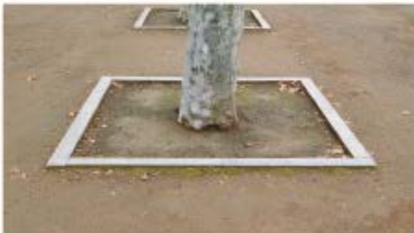
Alcorque de piedra en pavimento de tierra
