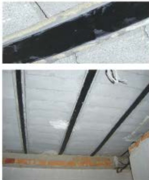
Refuerzo de viguetas con bandas de fibra de carbono y detalle
