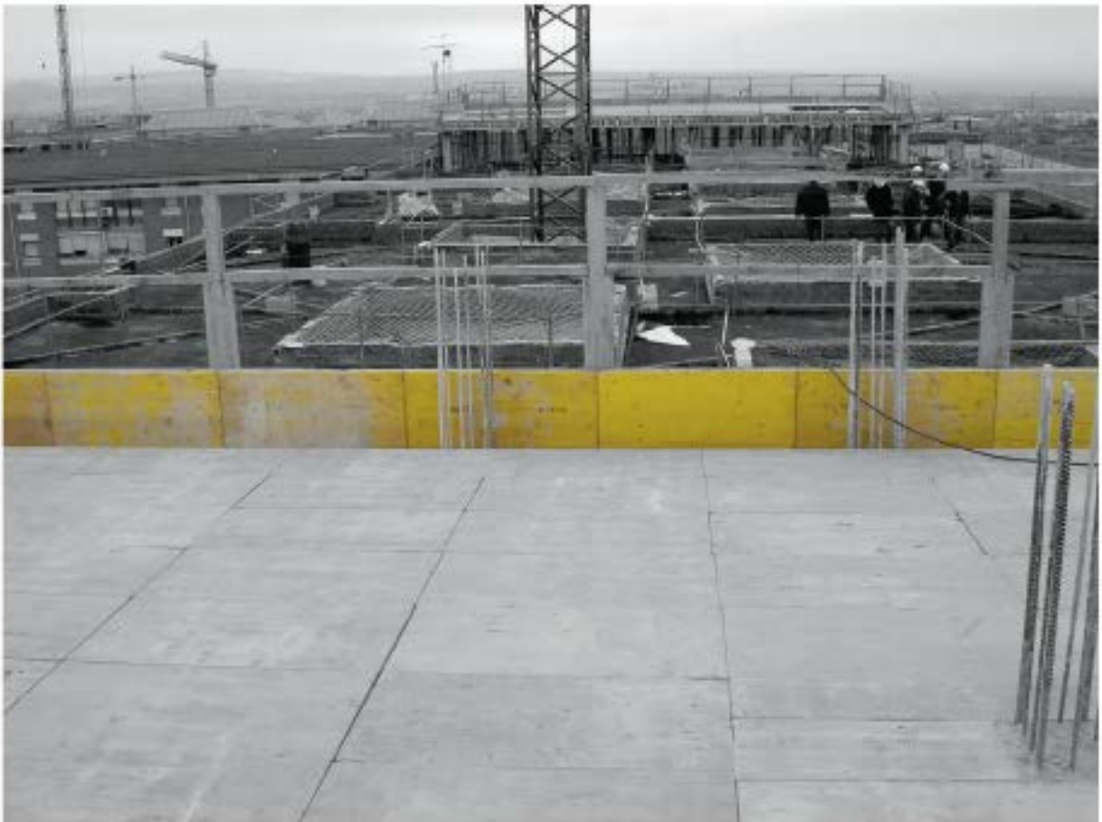
Tabica encofrado forjado (amarillo)
