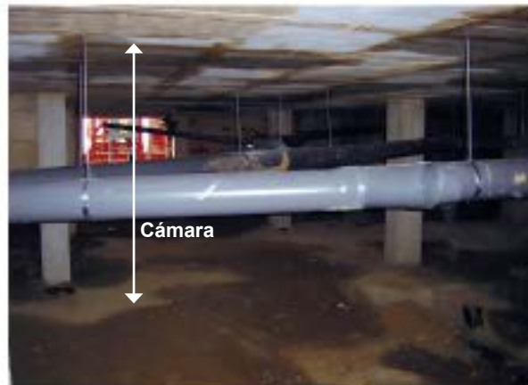
Interior: cámara de gran tamaño con la red de saneamiento colgada
