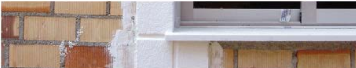
Muestra de junta de contracción en el futuro revestimiento monocapa
