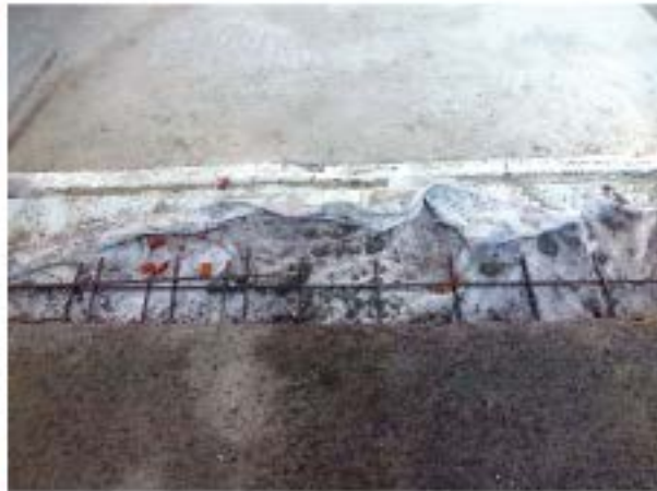
Solera armada sobre velo geotextil
