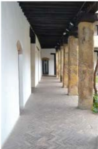
Galería abierta a patio en planta baja
