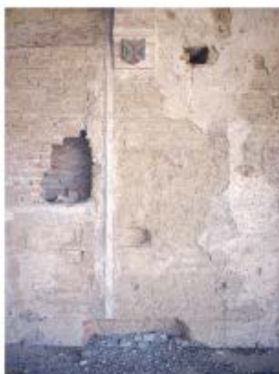
Maestras clásicas sobre muros maestros
