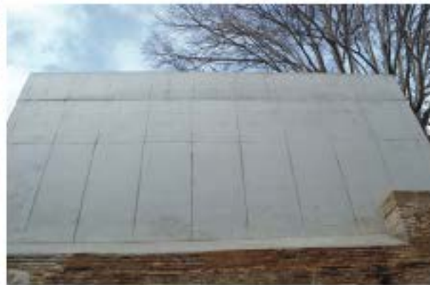
Muro de hormigón visto
