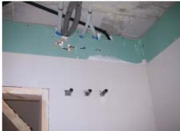
Alicatando sobre placas hidrófugas
