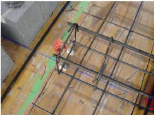
Separadores – calzos de hormigón
