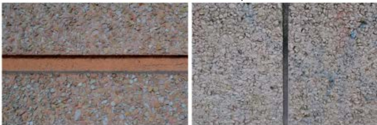
Detalle entrecalle o rehundido en mortero monocapa
