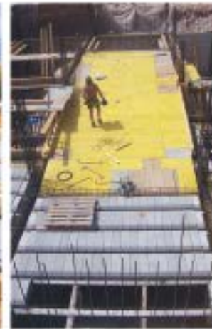
Encofrado de forjado
