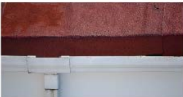
Canto (vuelta) de lámina autoprotegida con gránulos minerales
