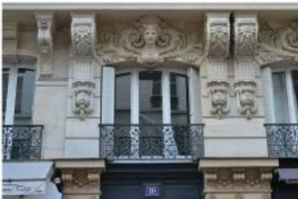
Balconera sin balcón
