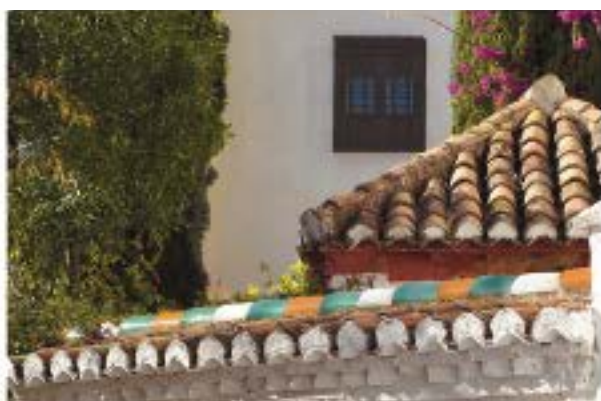
Tejas árabes (cobijas sobre canales) y vidriadas de varios colores
