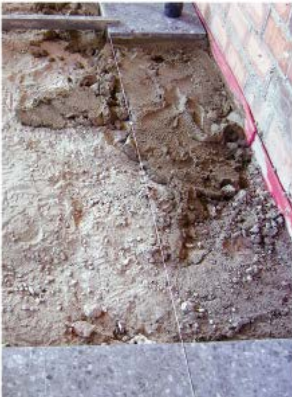
Lámina (color rojo) volteada contra pared y protegida con arena
