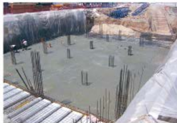
Hormigonando losa sobre el terreno
