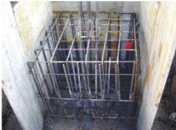
Armadura de encepado sobre pilote sencillo (el círculo de abajo)
