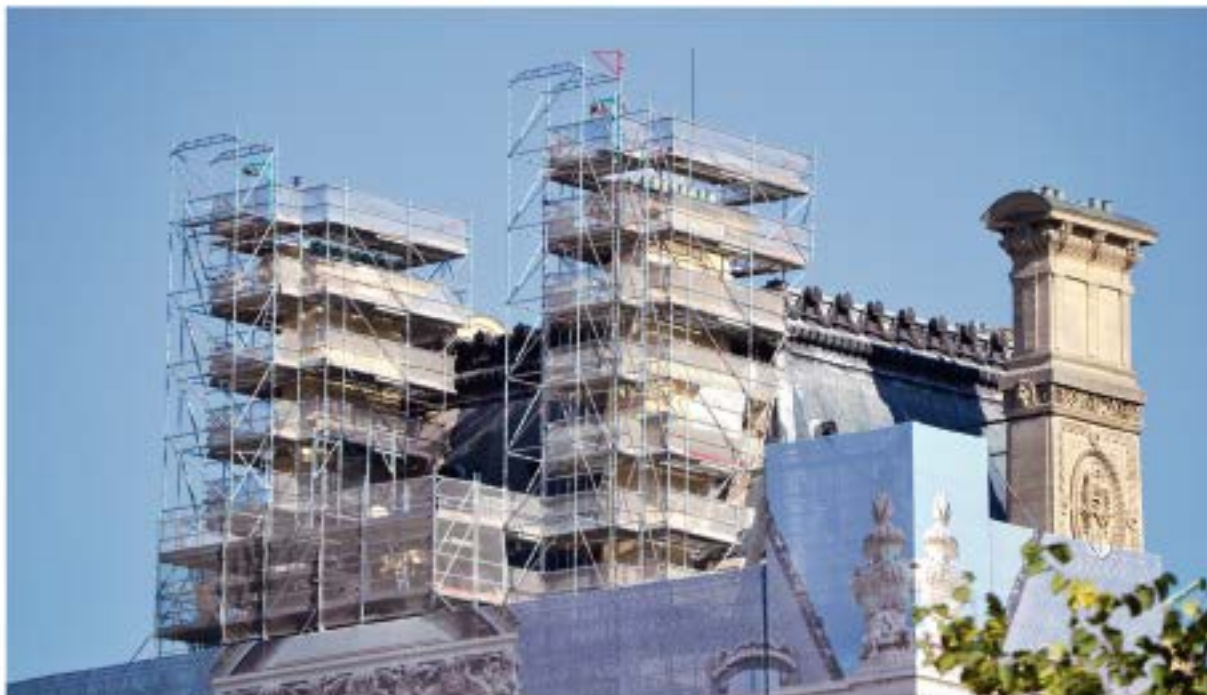
Súper-estructura de gran andamiada
