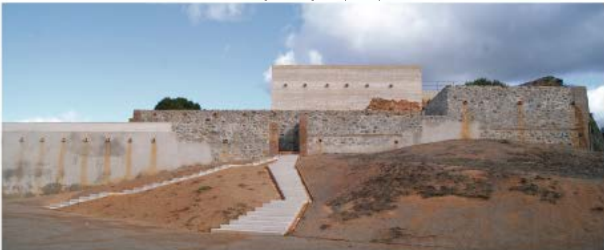
Combinación muros de mampostería y hormigón
