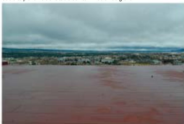
Azotea no transitable con pavimento cerámico
