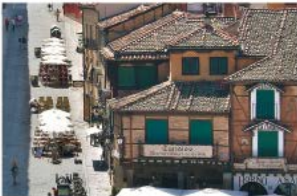
Singular: tejados a la segoviana, sólo con tejas canales y refuerzo de hiladas de cobijas
