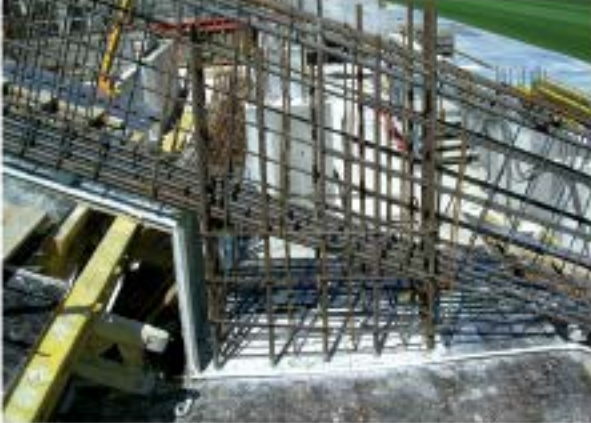
Preparando viga inclinada de hormigón armado
