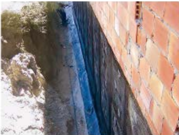
Lámina asfáltica impermeabilizando un muro
