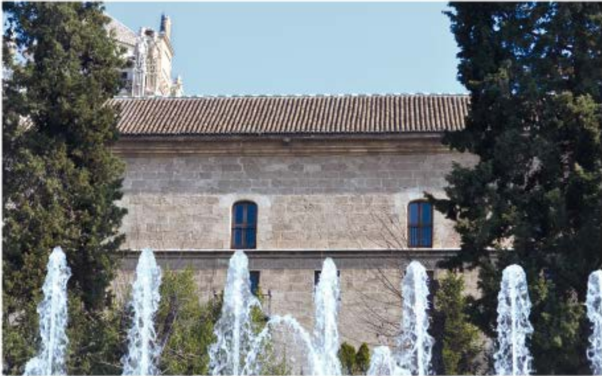
Muro de sillería con cornisa intermedia (imposta)
