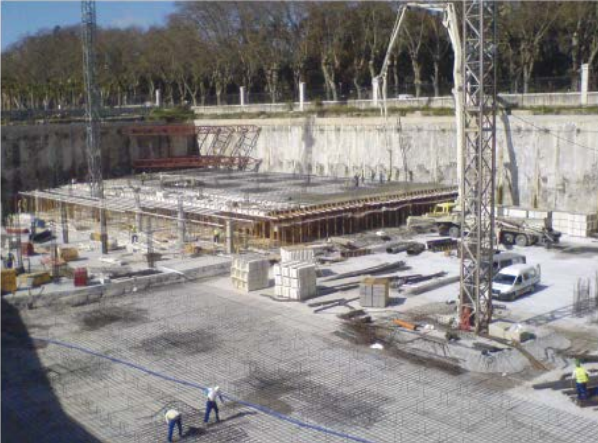
Arranque estructura de hormigón armado sobre losa de cimentación (en primer término)
