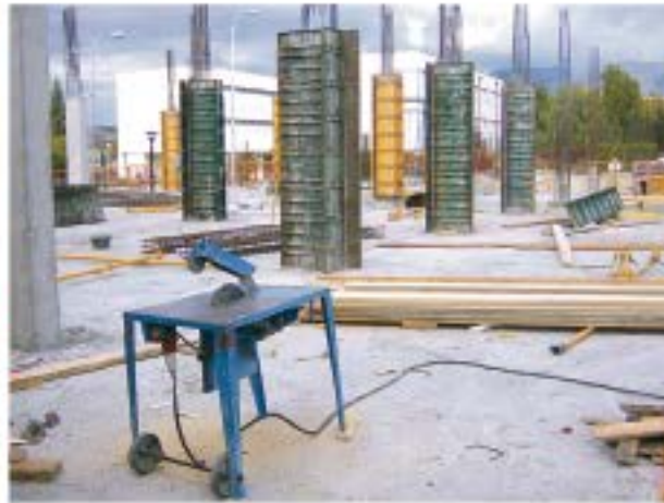
Encofrado de pilares
