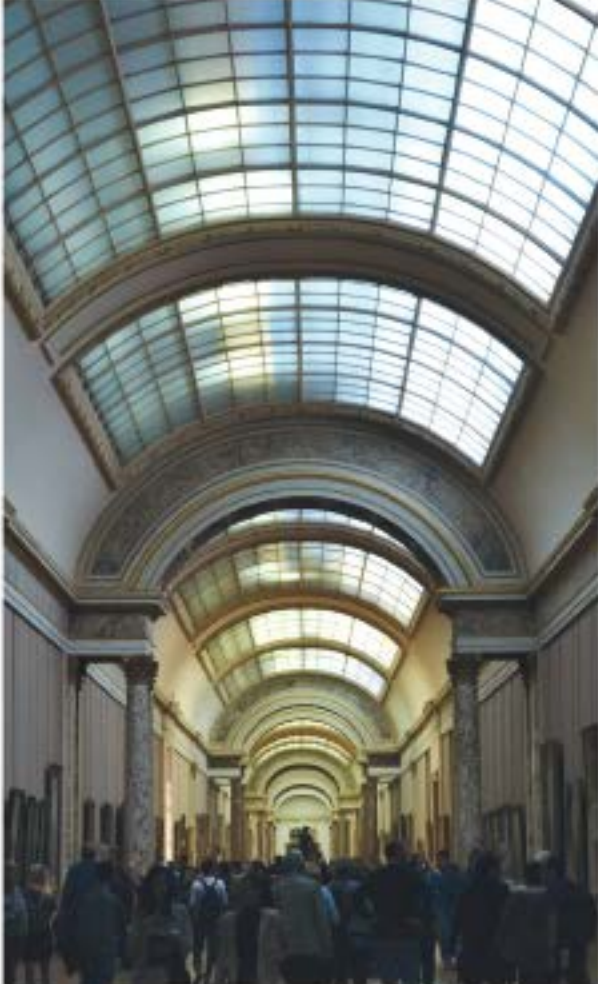
Bóveda de cañón (semicilíndrica)
