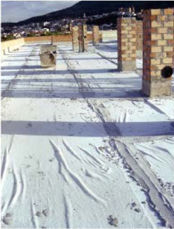
Velo geotextil separador de capas, en cubierta plana
