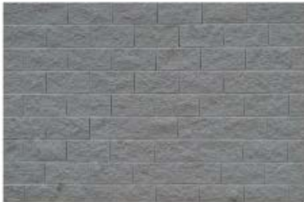
Aparejo a sogas de bloques de hormigón
