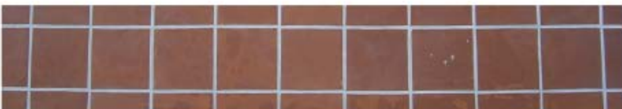
Junta ancha en acera de gres
