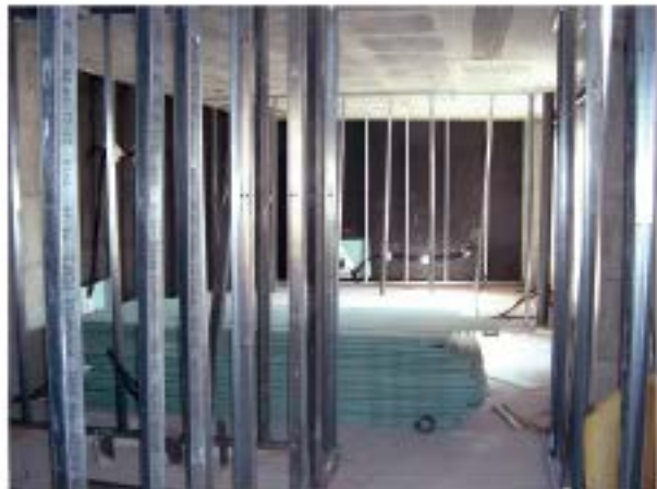
Replanteo con los montantes. En el suelo, las placas verdes, hidrófugas
