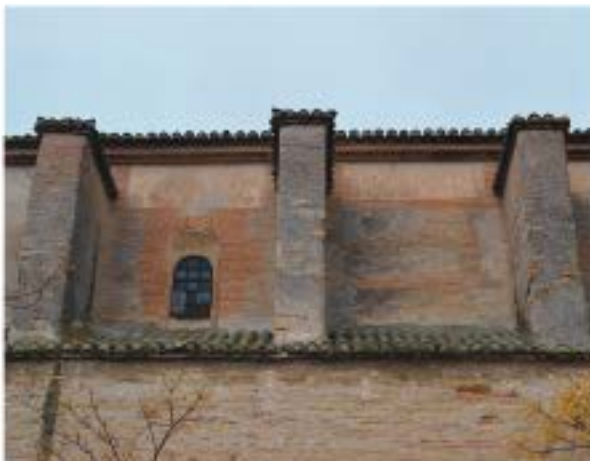
Entre los dos tejados: entrepaños entre contrafuertes
