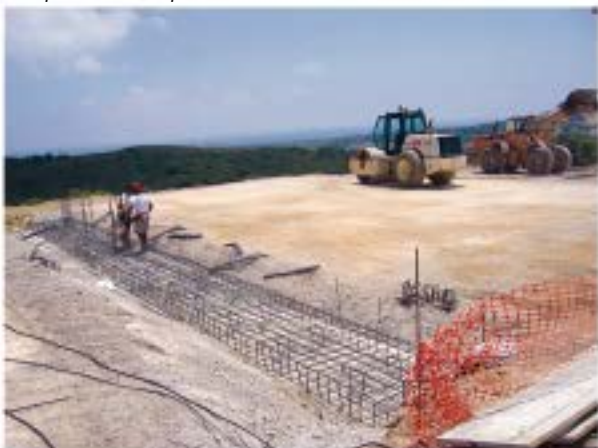
Compactación de explanada con maquinaria pesada
