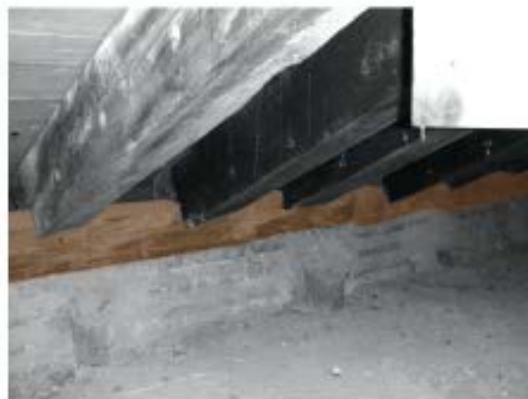
Durmiente sobre muro de ladrillo
