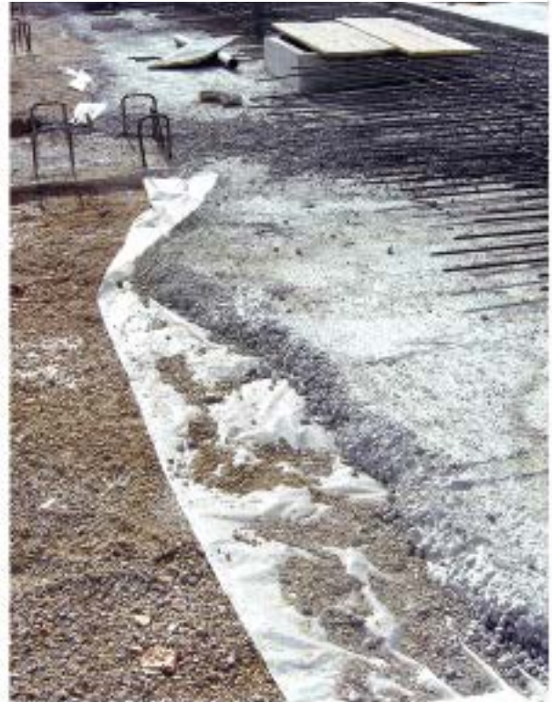
Lámina de polietileno anticontaminante
