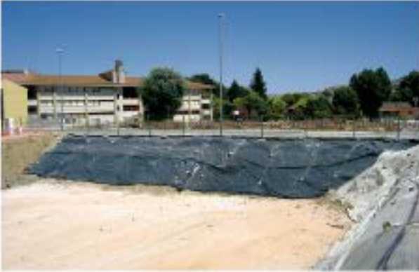
Talud protegido para evitar erosión
