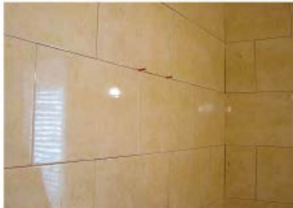
Separadores de azulejos para junta estrecha
