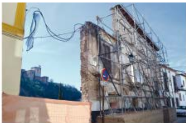
Andamio estabilizador de fachada
