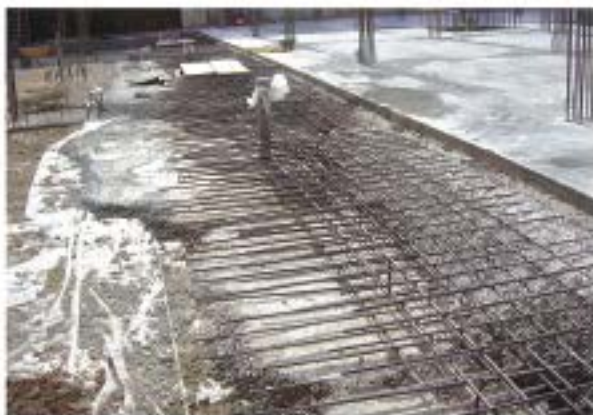
Hormigonando losa sobre pilotes
