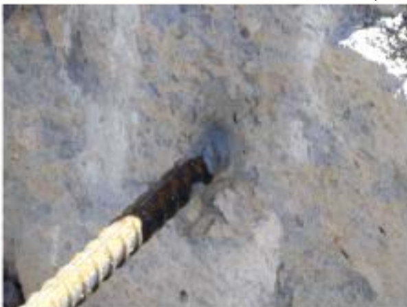
Anclaje de barra en hormigón, mediante resinas (color gris)
