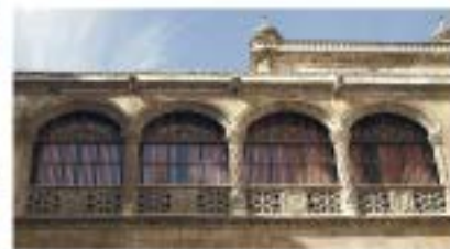
Arcada de arcos rebajados
