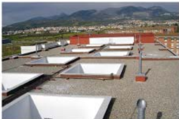
Cubierta plana no transitable con terminación de grava
