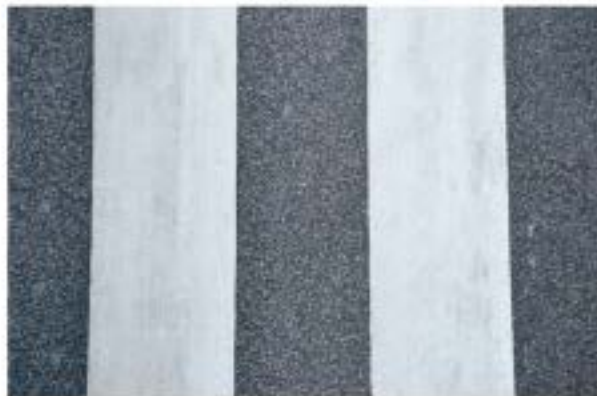
Aglomerado asfáltico en calzada
