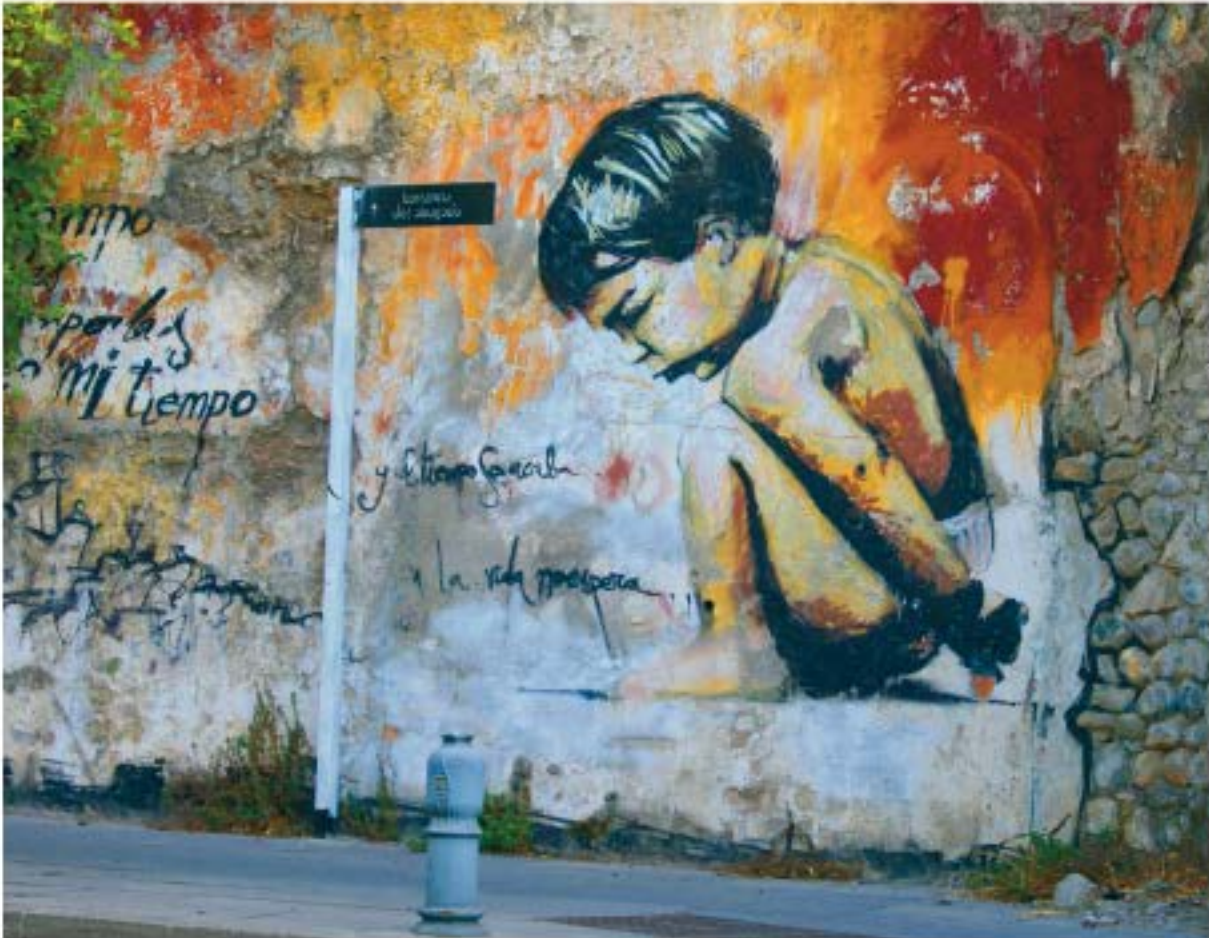
Intradós muro de contención de calle
