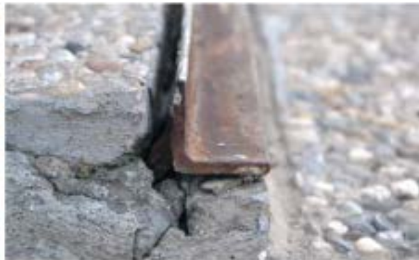
Angular utilizado en sustitución de la arista de peldaño
