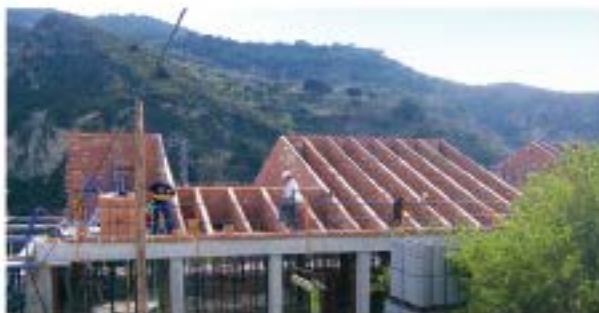
Empalomado de ladrillo para cubierta inclinada
