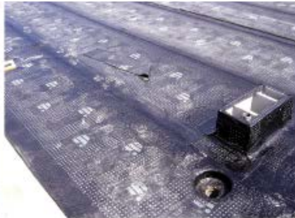
Impermeabilización cubierta plana con lámina asfáltica
