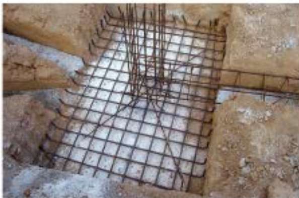
Preparando zapata aislada para homigonar
