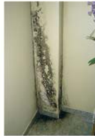
Violentas humedades de condensación en pilares de fachada
