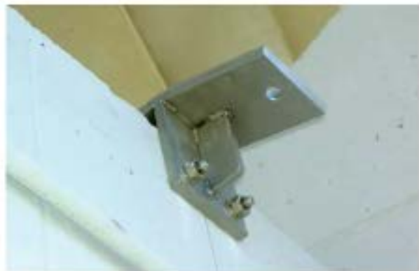
Sistema de placas de anclaje
