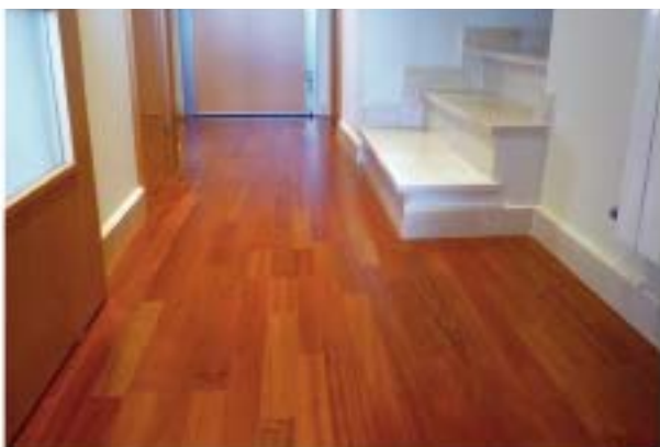
Entarimado de tablas machihembradas
