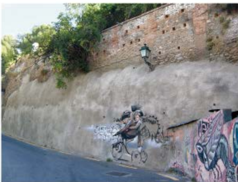
Gunita estabilizadora del terreno sobre el que apoya el muro superior
