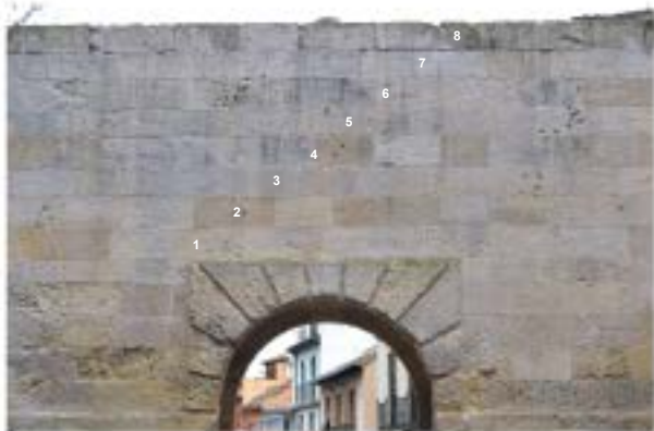
8 hiladas de sillares sobre el arco. La de abajo siempre es la primera
