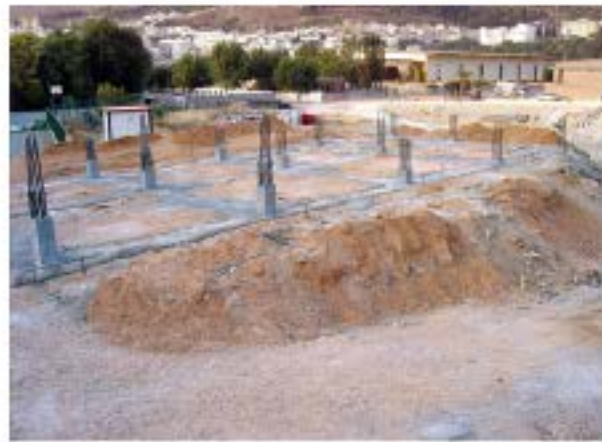
Enanos para forjado antihumedad y de distintas alturas por cambios de nivel
