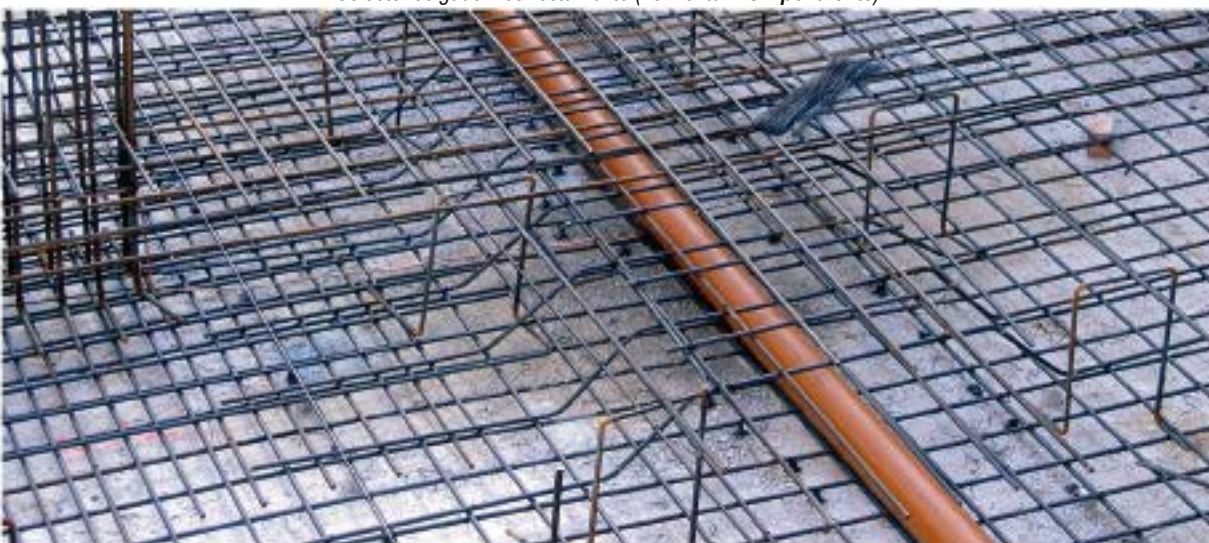
Colector empotrado ("encapsulado") en losa de cimentación
