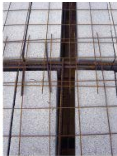
Nervios de hormigón armado en forjado reticular
