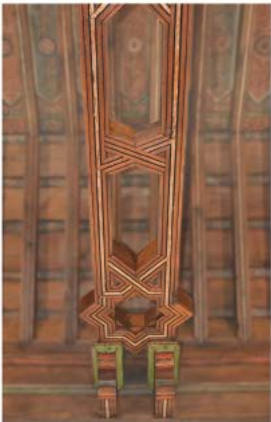
Tirante pareado y decorado en una cubierta de "par y nudillo"
