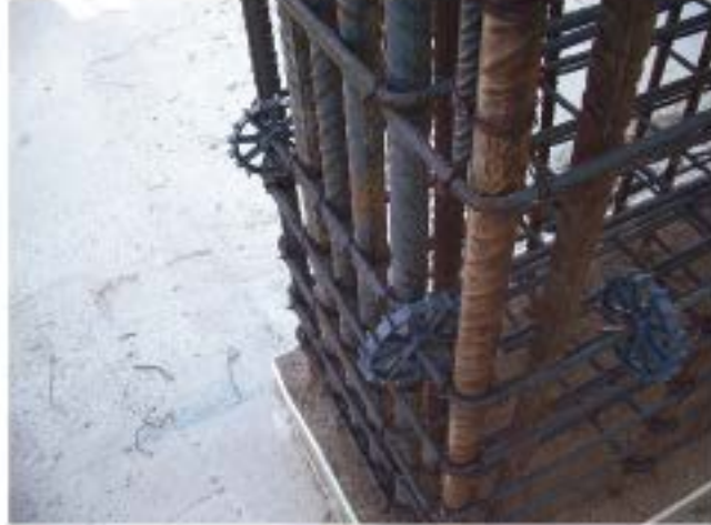
Separador de pvc para encofrado vertical
