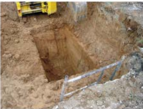
Calicata en terreno
