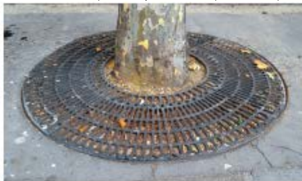
Alcorque de "fundición" (aleación hierro + carbono)
