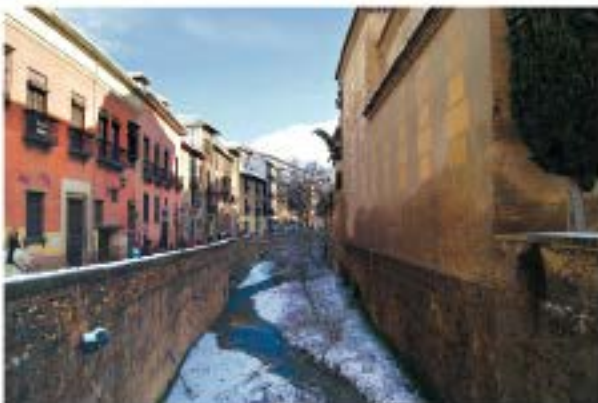
A la derecha, gran altura de la humedad capilar debida al río
