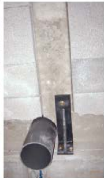
Refuerzo de apoyo-vigueta tras taladrarla
