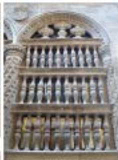
Balaustrada de triple altura
