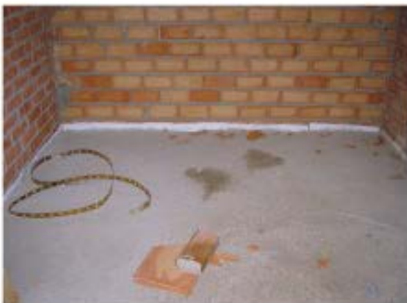
Preparando junta perimétrica en pavimento interior
