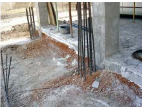
Encachado con material granular rojizo bajo plástico
