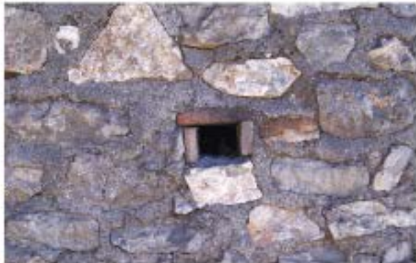
Mechinal de drenaje en muro de mampostería
