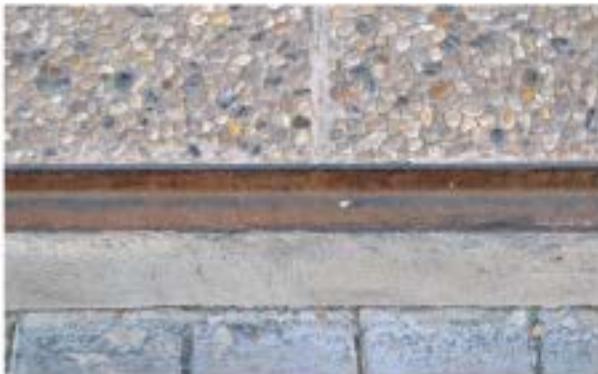
Angular utilizado en sustitución de la arista de peldaño
