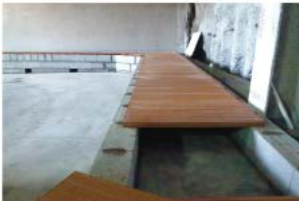
Colocando rasillones para formalizar un tablero horizontal
