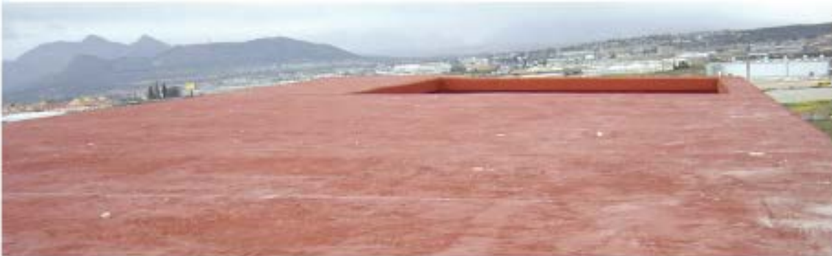
Impermeabilización marquesina con aplicación 'in situ' de caucho armado
