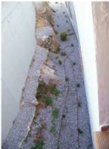
Pasillo de drenaje con grava
