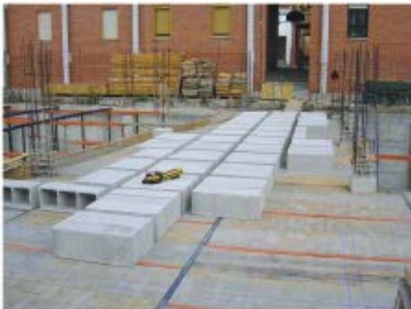
Casetones de hormigón para forjado reticular (bidireccional)
