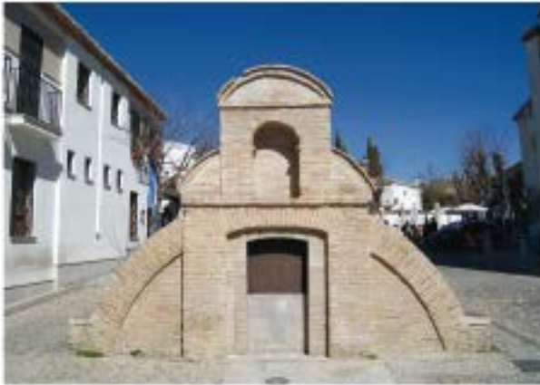
Antiguo aljibe urbano de 62 m³ de capacidad
