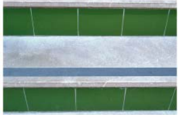
Tabica de gres verde bajo huella de piedra sin bocel
