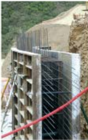
Encofrado de muro
