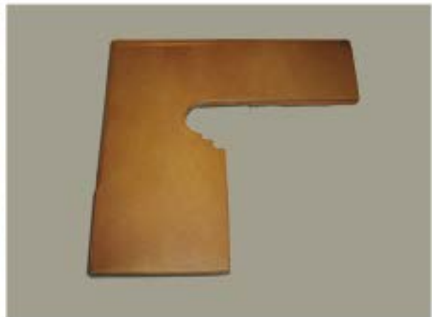
Zanquín adaptado a huella con bocel
