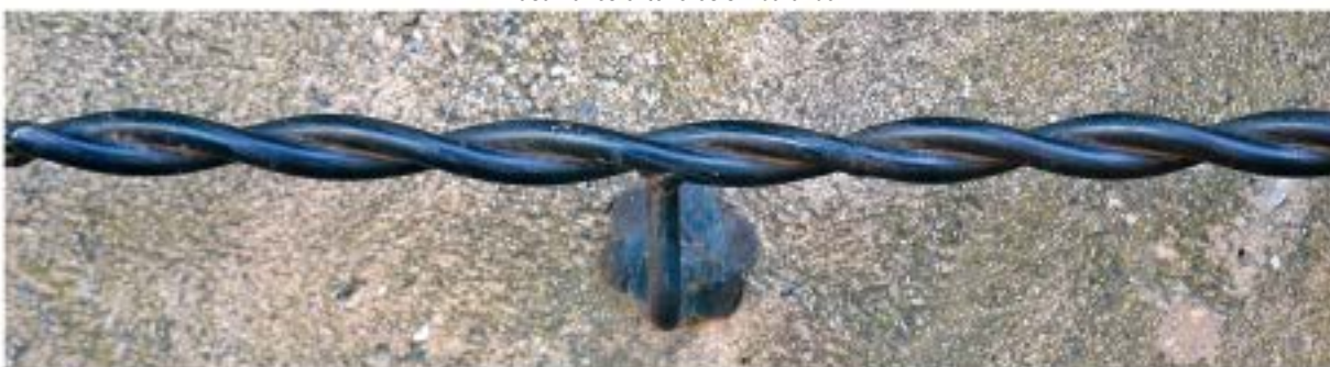
Detalle pasamanos pared (doble barra lisa de acero entrelazada)
