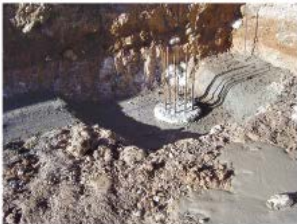
Cabeza de pilote ‘in situ’ de 55 cm de diámetro
