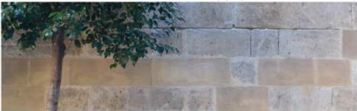
Sillería muy restaurada con aparejo libre
