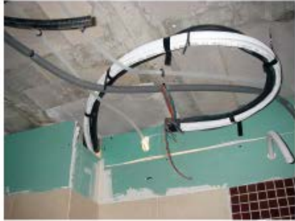
En color blanco, tubo pre-aislado con coquilla de polietileno reticulado
