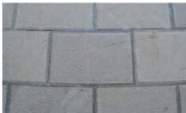
Pavimento de baldosas de piedra abujardada (gris claro) El borde de las baldosas es la misma piedra pero pulida
