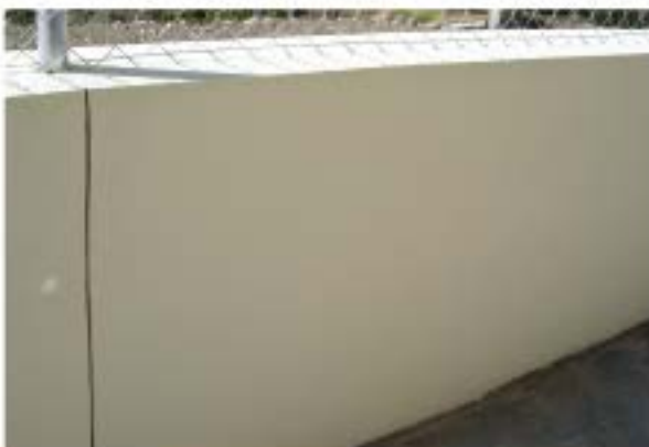
Junta de retracción o contracción en murete
