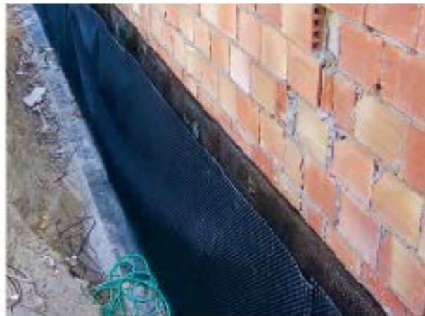
La misma lámina protegida por otra de drenaje
