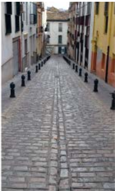
Calzada de adoquines con cuneta central
