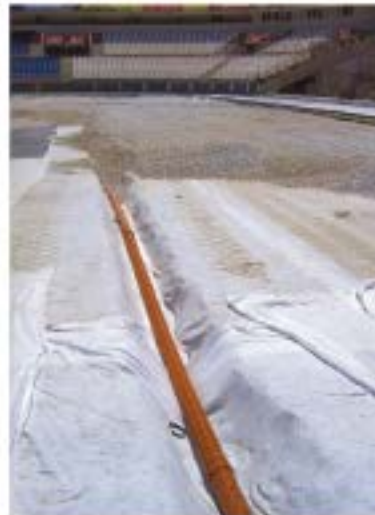
Drenaje de pista deportiva con tubo “Dren”
