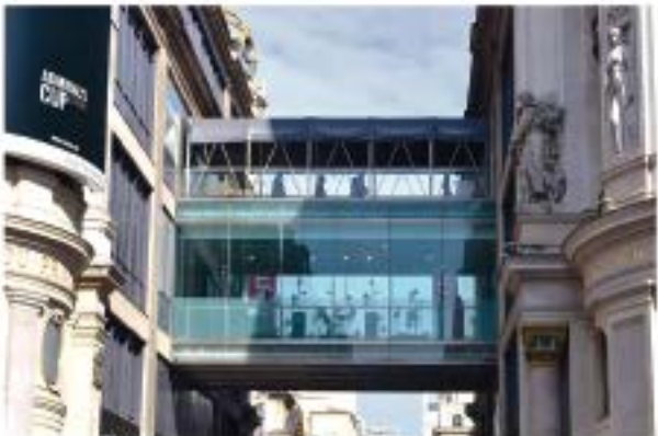
Pasarela de doble altura entre edificios
