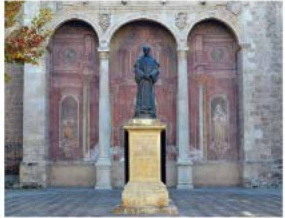
Pórtico con arcada de medio punto
