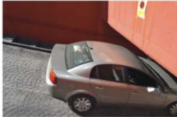
Cabezada de rampa muy justa. Esquina achaflanada para que los coches no rocen
