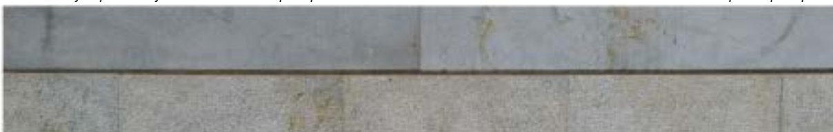
Detalle: la tira superior está apomazada, y la inferior abujardada
