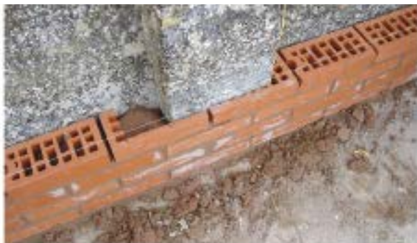
Emparchando pilar con recorte de ladrillo perforado
