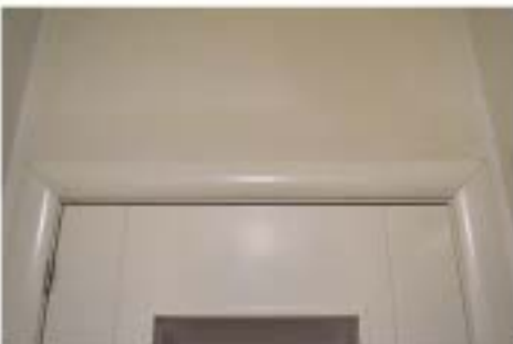
Tapajuntas curvo de puerta interior de paso
