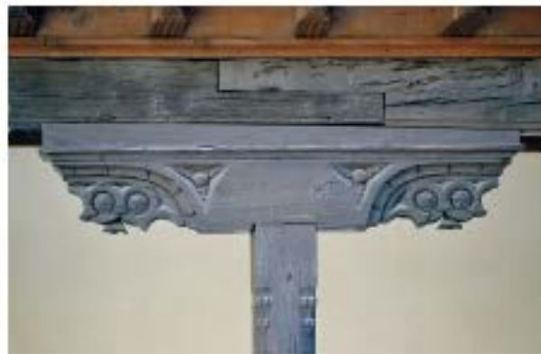
Zapata de madera sobre pie derecho
