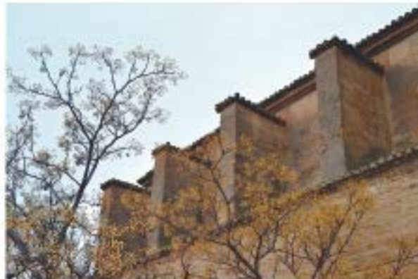
Contrafuertes sin arbotantes
