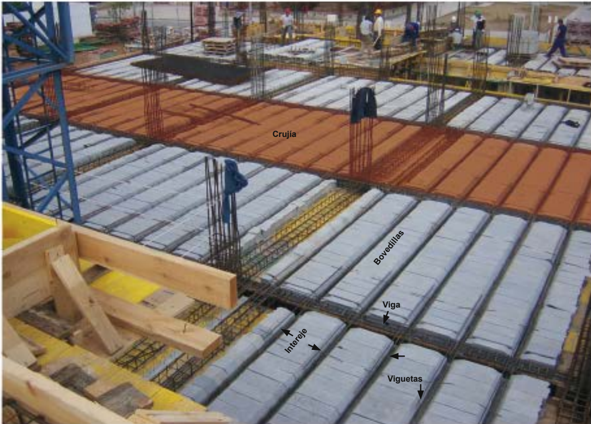
Forjado unidireccional visto desde la cara superior antes de ser hormigonado
