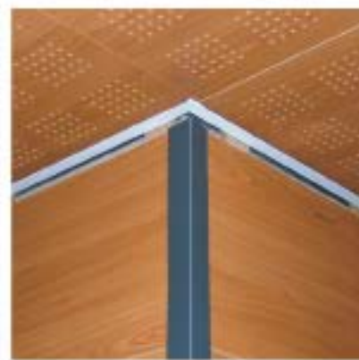
Cantonera en empanelado de madera
