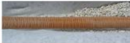
Detalle tubería dren
