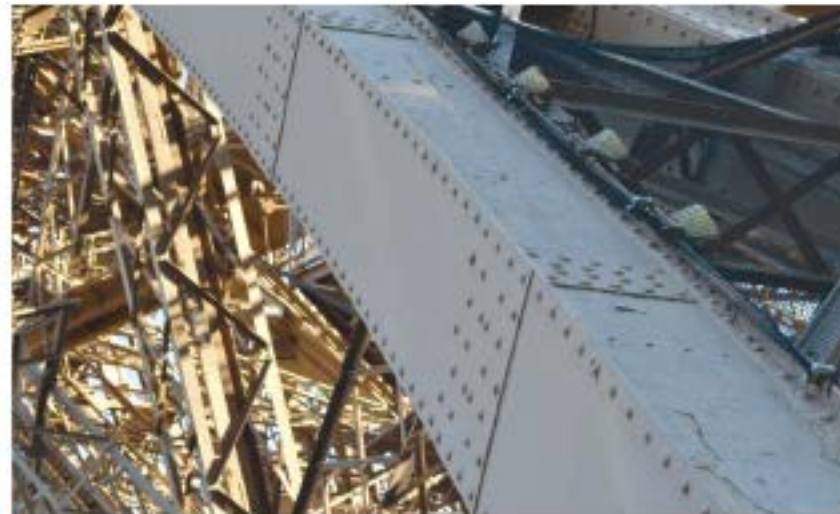
Macro-estructura de acero con uniones roblonadas
