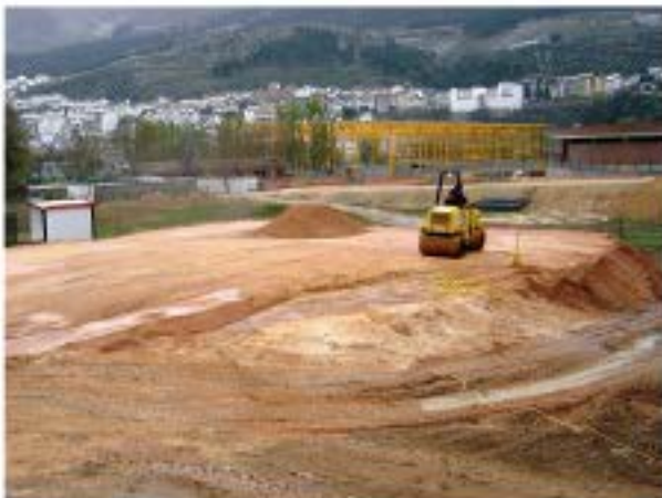
Compactando una plataforma
