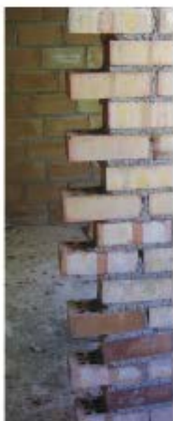
Enjarje de ladrillos perforados
