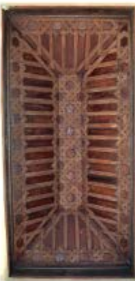
Estructura de madera
