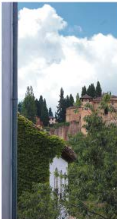
Bajante de chapa de acero galvanizado
