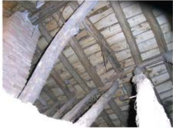
Cubierta de rollizos
