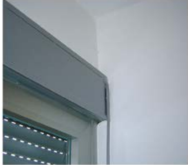
Capialzado compacto colocado
