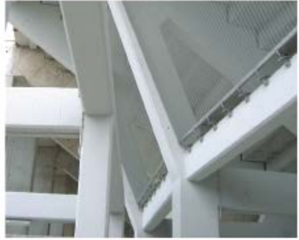
Nudos de hormigón : vigas-pilares / vigas-pantallas
