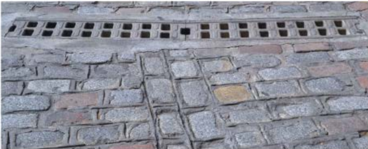
Canal – sumidero instalado en vial
