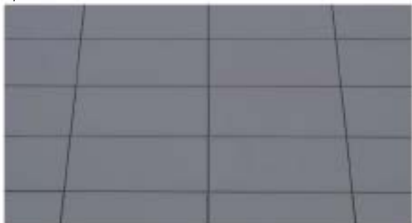
Aplacado en fachada ventilada
