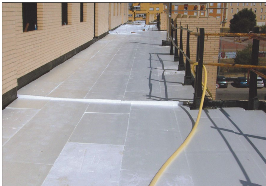
-Imagen K- Extendido y acople lateral de los paneles de poliestireno extruido formando la capa de material aislante de una cubierta invertida.
