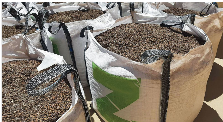
-Imagen C- Recepción en obra de diferentes sacos llenos de sustrato para una cubierta ajardinada.
