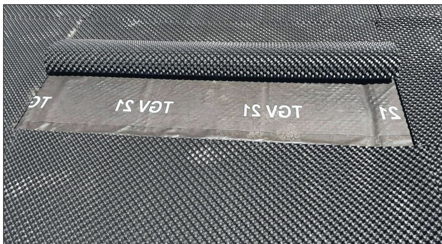
-Imagen M- Colocación de las subcapas especiales. Superiormente puede apreciarse una lámina nodulada de polietileno de alta densidad.
