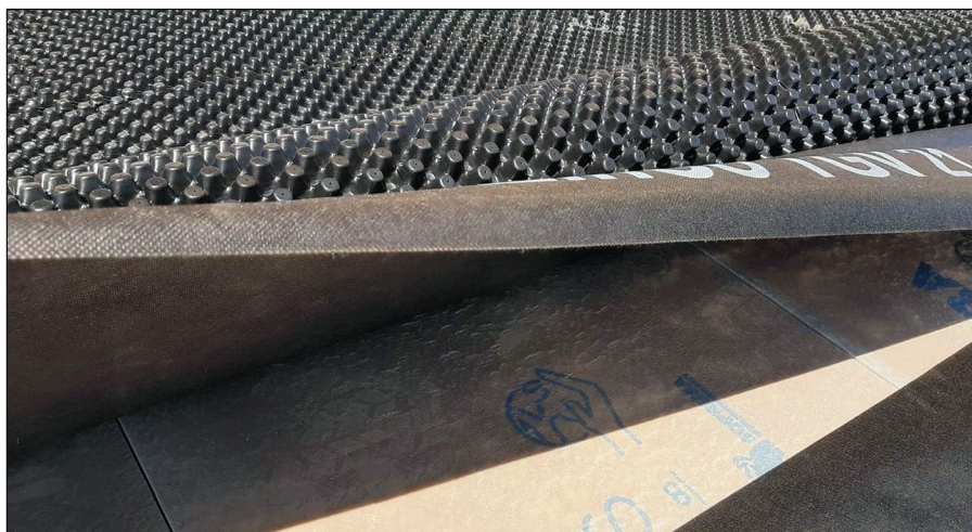
-Imagen E- Vista de las diferentes láminas y productos que conforman las subcapas especiales.
