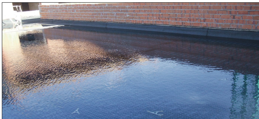
-Imagen J- Proceso de comprobación de la estanqueidad de una impermeabilización.
