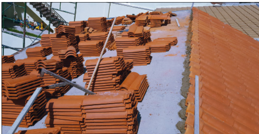
-Imagen E- Proceso de distribución y de colocación de las tejas sobre los faldones de cubierta.
