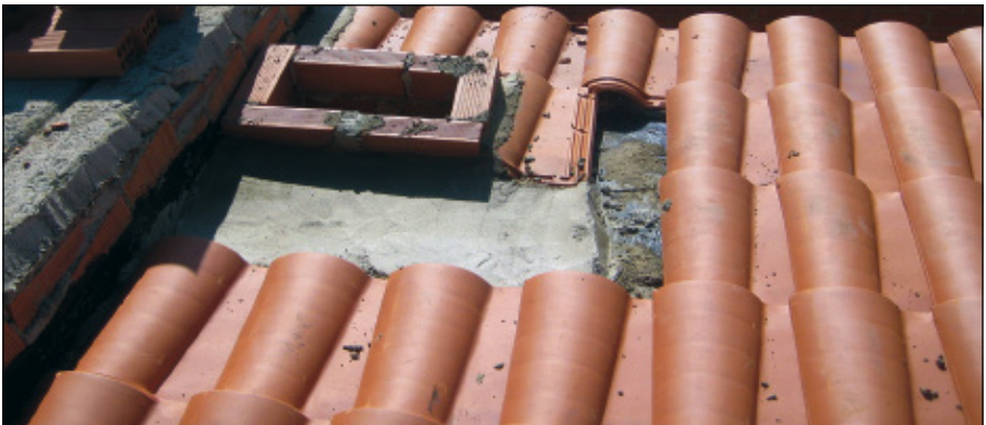
-Imagen R- Inicio del proceso de resolución de un encuentro de un faldón con un conducto de ventilación.
