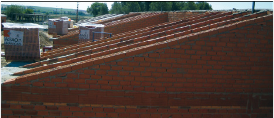
-Imagen N- Vista del lateral de una cubierta en ejecución: hastial realizado con fábrica de ladrillo perforado.
