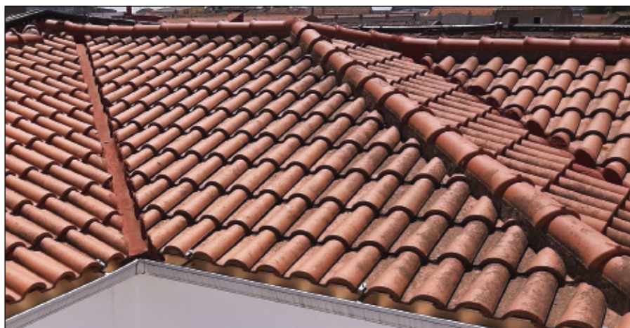
-Imagen C- Vista de una cubierta de tejas con sus limahoyas, limatesas y cumbres.
